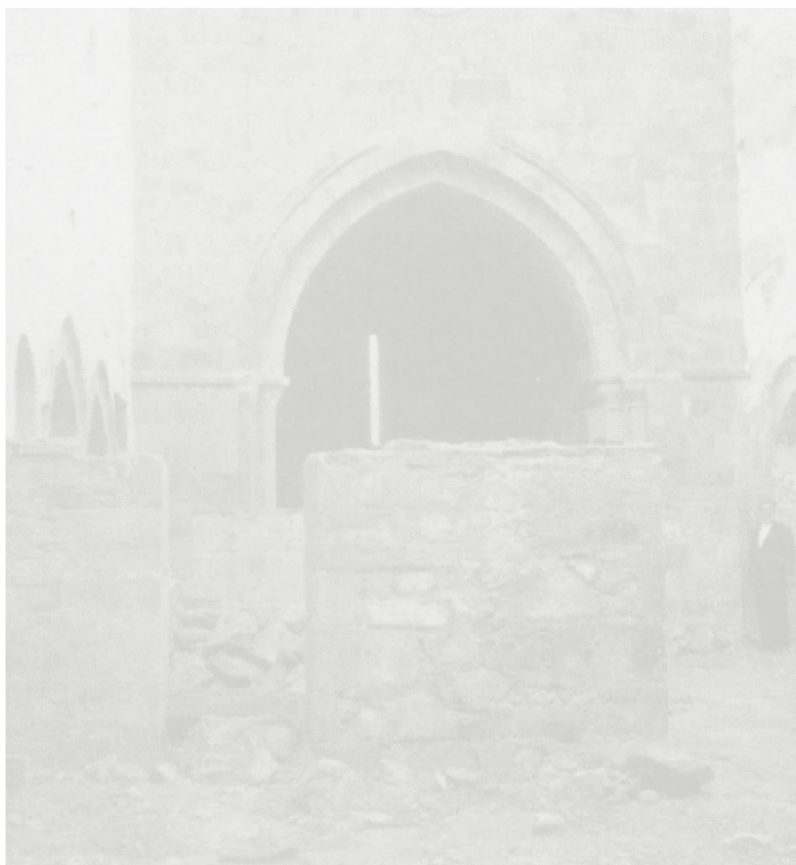
Interior, detalle del refugio antiaéreo levantado en la nave. Fotos Luis Menéndez-Pidal, 1939
