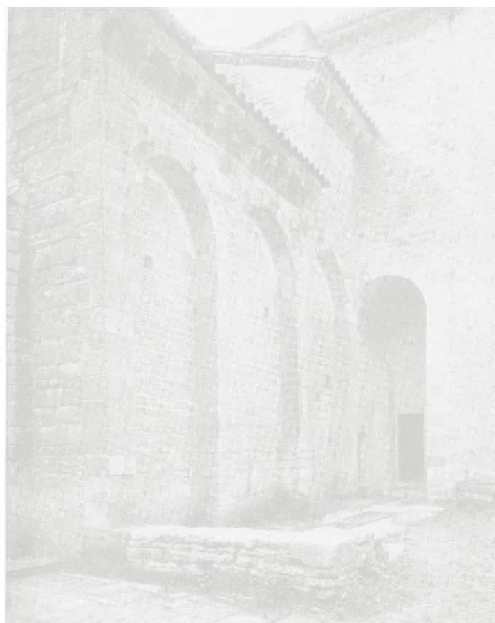
La Cámara Santa de la catedral de Oviedo después de la reconstrucción
