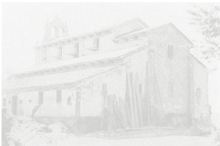
Iglesia de San Salvador de Priesca, vista exterior durante los trabajos de restauración
