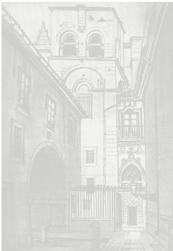
La torre Vieja de la catedral de Oviedo, antes de la demolición, dibujo Menéndez-Pidal, 1919
