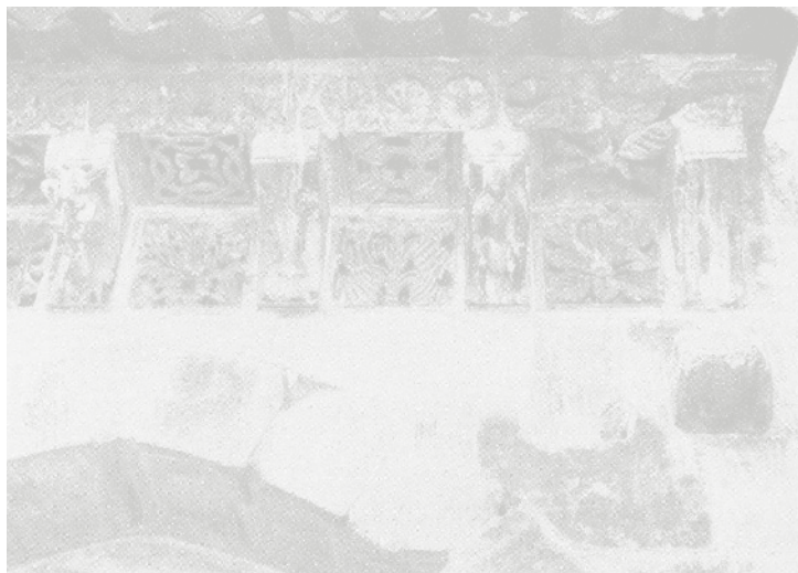
Cornisa exterior de la Cámara Santa ya recompuesta
