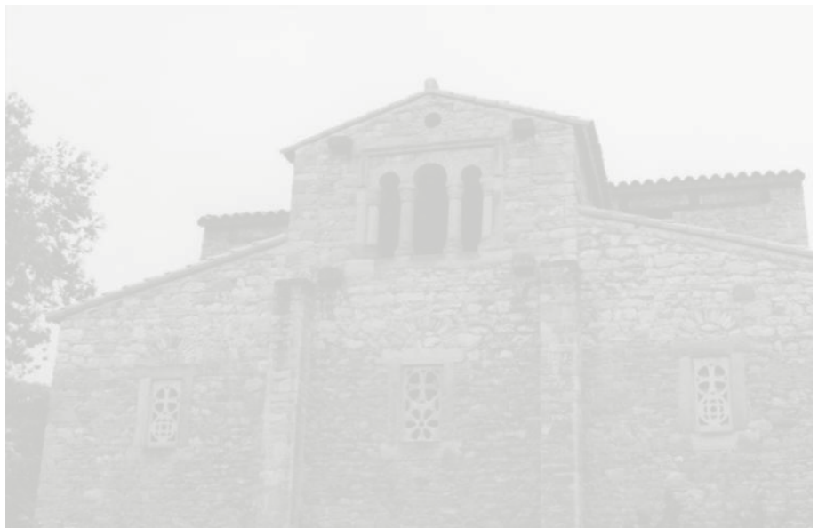
Ábside reconstruido con los faldones en su estado final. Foto del autor
