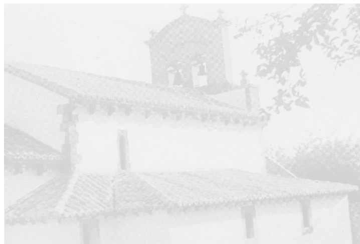
Iglesia de San Salvador de Fuentes, estado restaurado. Foto Luis Menéndez-Pidal, 1940
