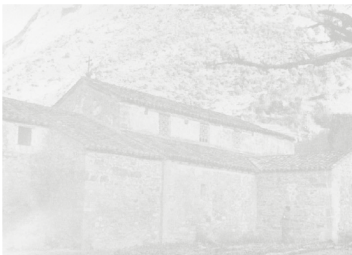
Iglesia de Santo Adriano de Tuñón, vista desde el exterior
