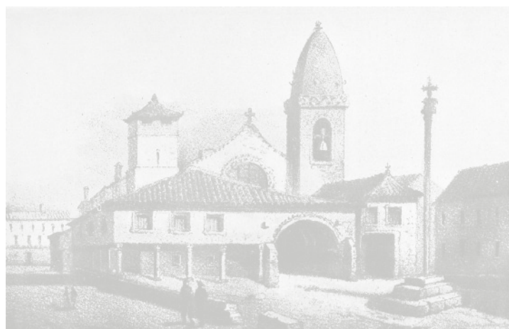
La iglesia de Santa María del Campo, estado antes de la restauración. Litografía de A. Villegas, 1850 aprox.
