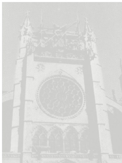
Hastial meridional durante las obras de recomposición, 1963
