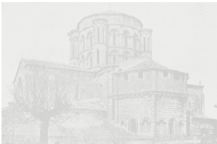
La colegiata de Toro, estado antes de la restauración
