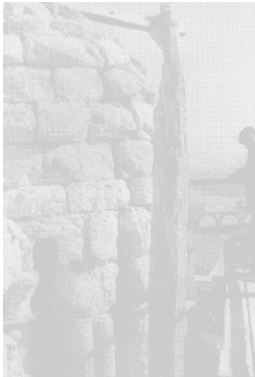
Catedral de Zamora, dovelas del cimborrio antes de la restauración
