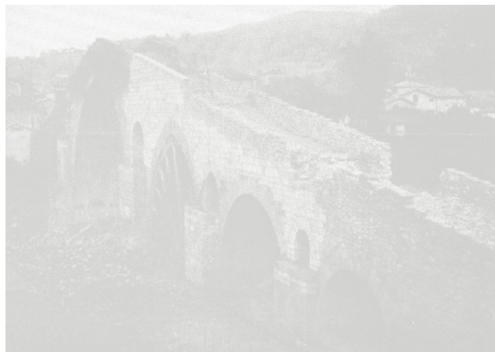
El puente de Cangas de Onís durante las obras de restauración. Foto Luis Menéndez-Pidal, 1941
