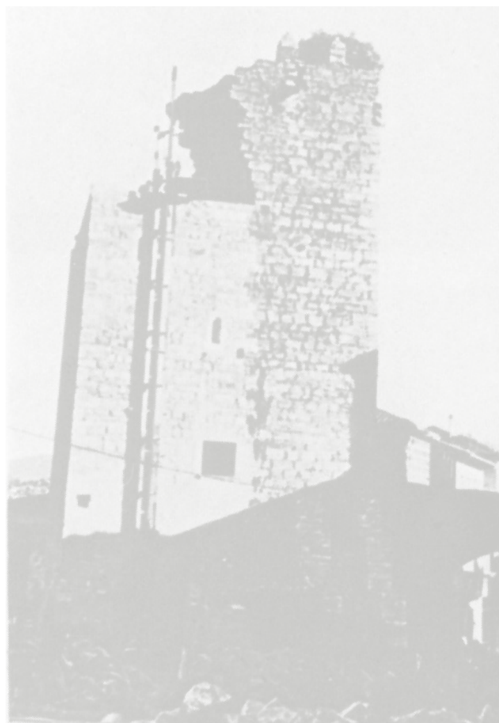
La torre de Salas durante las obras de reconstrucción
