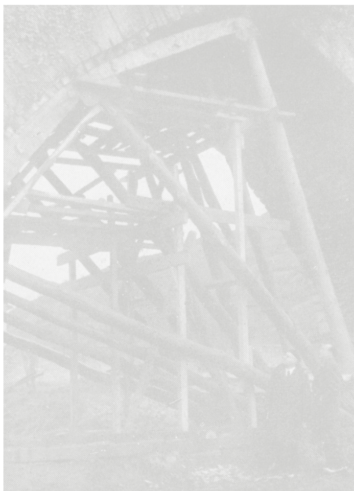
El puente de Cangas de Onís durante las obras de restauración. Foto Luis Menéndez-Pidal, 1941
