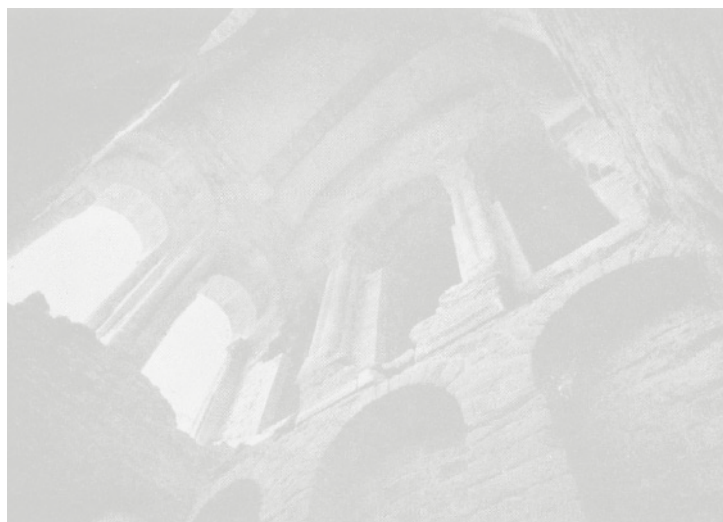
Iglesia de Santa María del Naranco, vista del interior durante las obras de restauración
