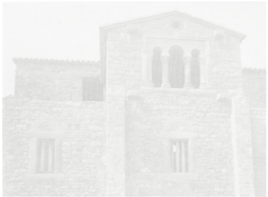
Ábside de Bendones, estado tras la primera hipótesis de reconstrucción en 1961
