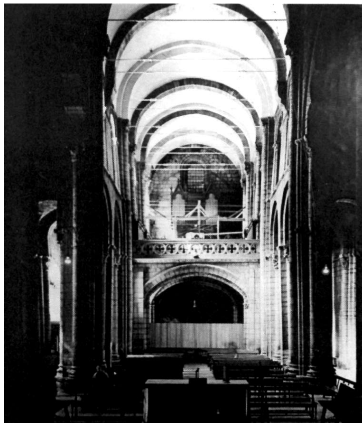
La colegiata de San Isidoro, estado restaurado con los tirantes metálicos, 1975
