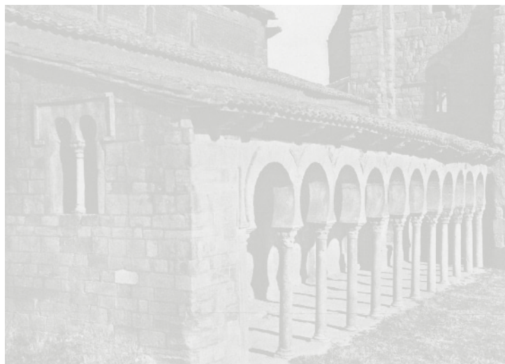
Iglesia de San Miguel de Escalada. Vista del pórtico meridional tras la restauración
