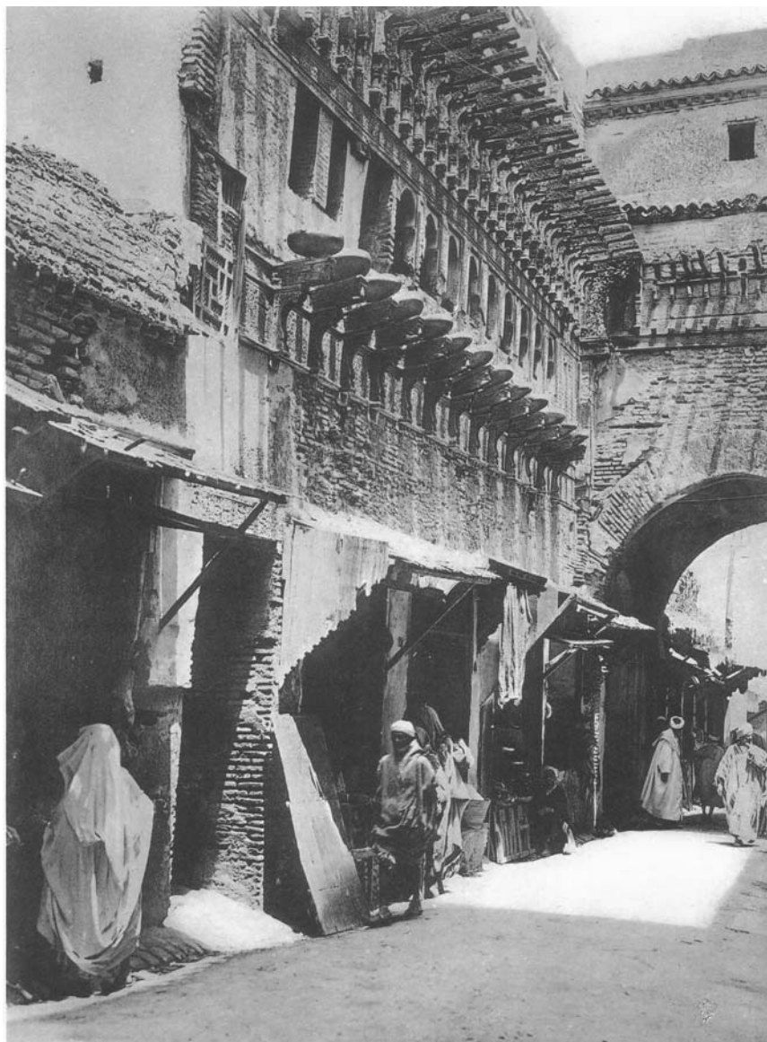
Lám.5. Minīna pública de Fez de 1357 frente al portal de la madraza Bā'In-niyya. Vista lateral de conjunto.
