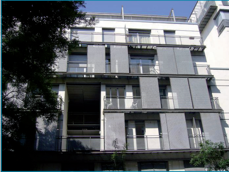
Imagen 3: Fachada. Detalle de los pasillos y de las celosías. Fotografía: M a Teresa Hontoria.
