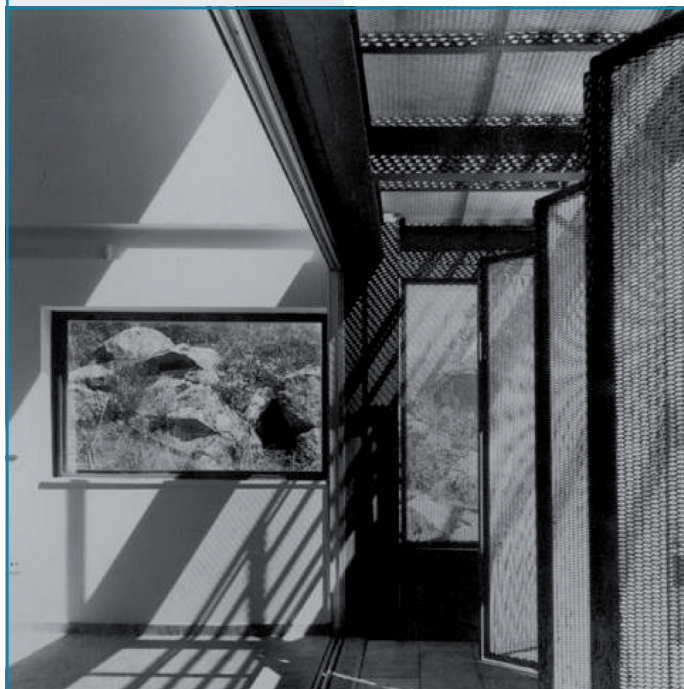
Imagen 4: Detalle de las celosías y ventanas tipo tramex.
