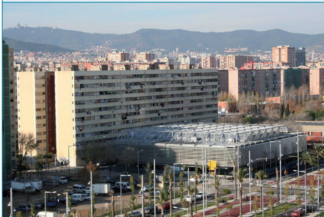
Imagen 5: Vista actual del conjunto: Centro Cultural y la Biblioteca. Fotografía: Cortesía de Monserrat Luesma.
