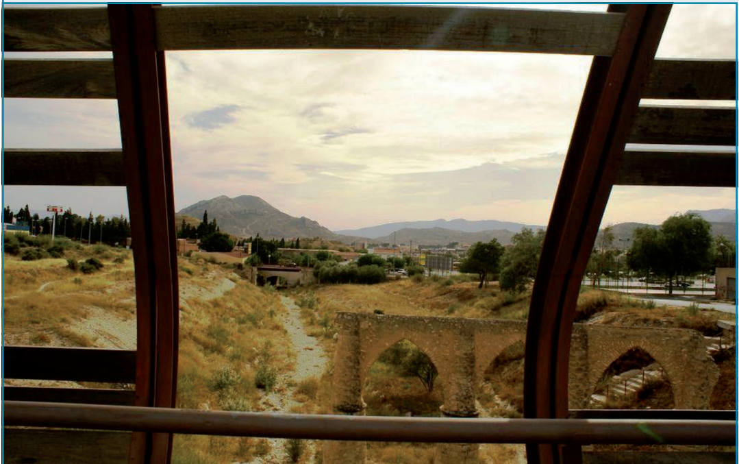
Imagen 6: Imagen actual de la pasarela y del contexto. Febrero, 2011.
