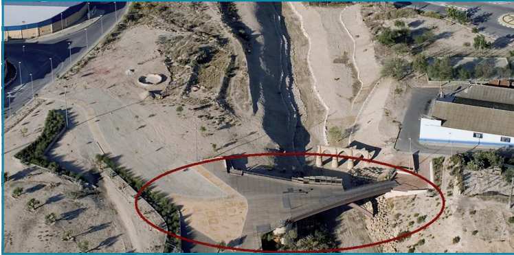
Imagen 2: Vista aérea de la pasarela y el acueducto
