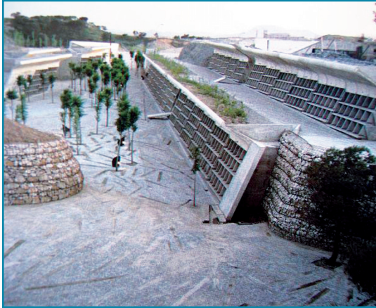
Imágenes 4 y 5: Zona de los nichos. Parte lateral con taludes de contención y detalle de la escalera de acceso al piso superior. Fotografías: Revista El Croquis .
