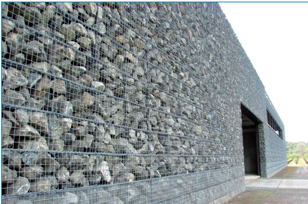
Imágenes 7 y 8: Bodega Dominus, California, EEUU. Arquitecto Herzog Meuron, 1997.
