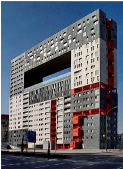
Imagen 4: Vista general del edificio a su terminación. Fotografía: M Teresa Hontoria.
