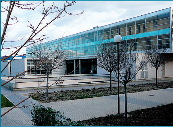
Imagen 8. Fachada y vista de los accesos abiertos. Fotografía: M a Teresa Hontoria.
