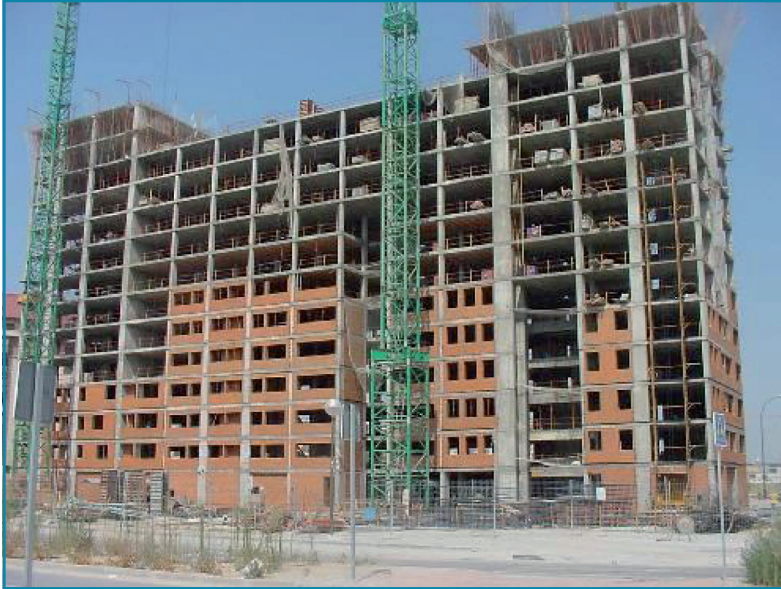
Imagen 4: En construcción, 2003. Fotografía: cortesía de Bernardo Fort.
