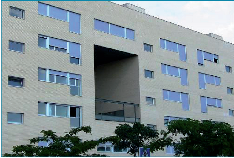
Imagen 2: Fachada exterior. Fotografía: M a Teresa Hontoria.
