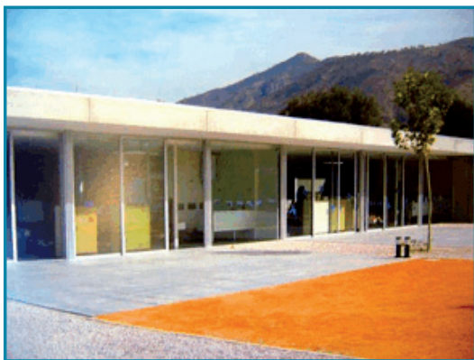
Imagen 3. Vista del patio y aulas. Fotografías: Revista Documentos de Arquitectura .
