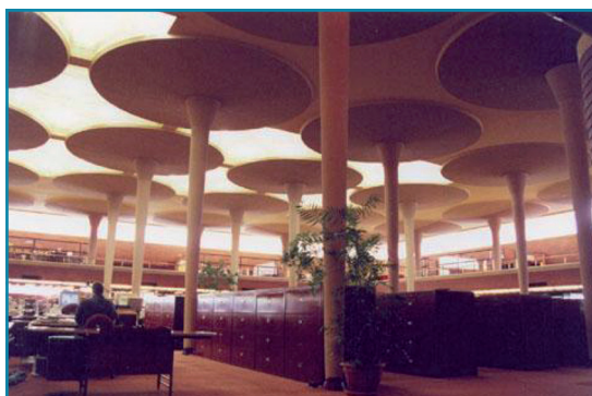
Imagen 5: Edificio Johnson Wright.
