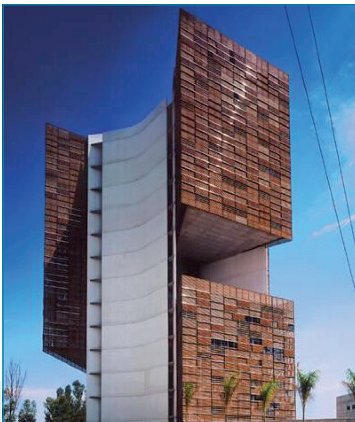
Imagen 5: Vista de la Torre Cube.
