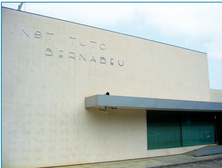
Imagen 4: Fachada principal del IB en Alicante. Fotografías: M a Teresa Hontoria.
