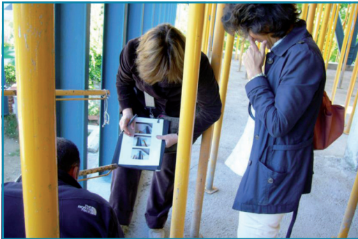
Imagen 3: Arquitectas visitando la obra. Fotografía: M a Teresa Hontoria.
