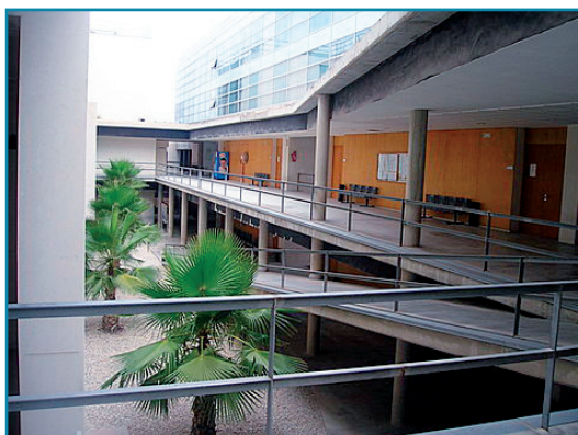
Imagen 7. Interior del edificio. Vista de los patios y pasillos. Fotografía: M a Teresa Hontoria.
