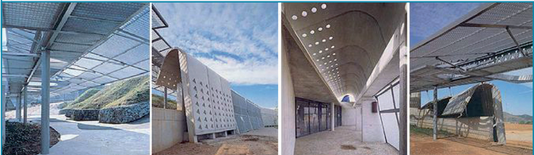
Imagen 8: Vistas de las cubiertas de rejilla, de las paredes de hormigón...
