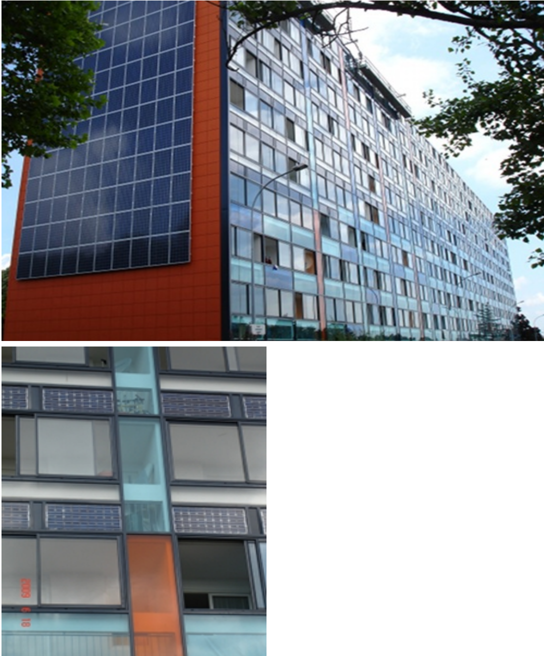
Figura II-51: Conjunto habitacional de 133 viviendas HLM construidas en 1965 en la calle Georges Sánd de Chenôve (Côte d'Or, Francia). Intervención de reciclaje llevada a cabo en 2009 por el baillieur OPH21 y el equipo de arquitectura Patrick Bidot. Instalación de subestructura de aluminio lacado en fachada que permite el cierre de balcones, y de paneles fotovoltaicos (Tenesol) sobre fachadas ciegas con base de aislante de espuma de poliuretano color naranja. Las 420 placas instaladas en el conjunto proporcionan una potencia media de 47,2 kwh. Un panel digital en la fachada ciega norte informa de la potencia instantánea, la total acumulada y las toneladas de CO2 que se han dejado de emitir a la atmósfera. Fuente: Michel Patois < www.orbitis.fr >
