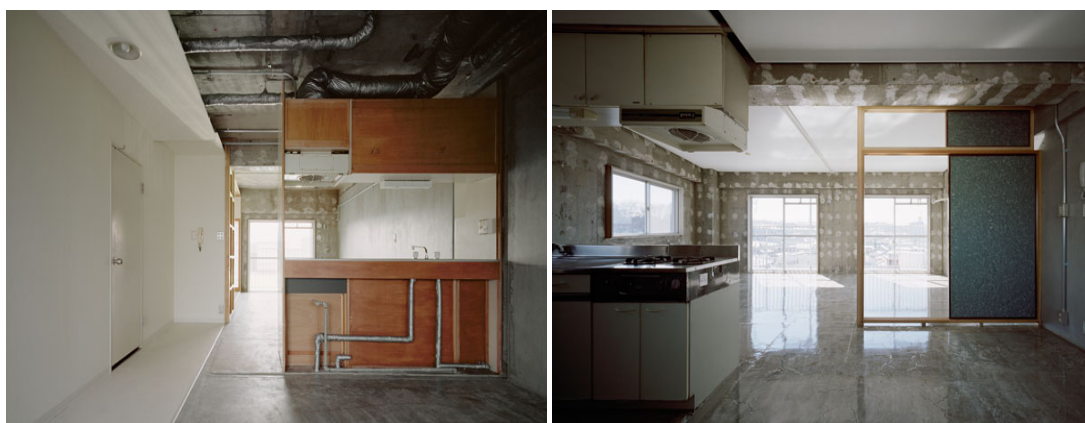
Figura II-55: Imágenes del interior de las viviendas del edificio Sayama Flats en Tokio. El proyecto de reciclaje ha consistido en este caso en reparar patologías en elementos constructivos, instalaciones y carpintería de fachada. Para el interior de las viviendas, la decisión de proyecto ha sido eliminar las compartimentaciones originales, instalando únicamente los núcleos húmedos y algunos elementos en los que el habitante pueda apoyarse para decidir cómo distribuir los usos y apropiarse del espacio. El proyecto fue ganador del premio Mies van der Rohe. en 2009 Fuente: estudio de arquitectura Schemata – Go Nagasaka.
