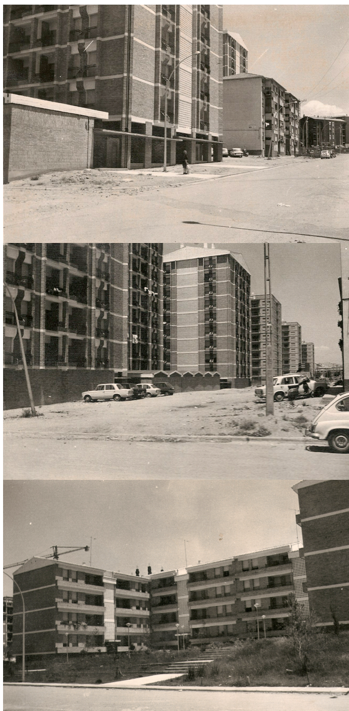
Figura II-29: Fotografías de final de obra del conjunto de 180 viviendas protegidas en el Sector IV del Plan Parcial del Polígono de Cartuja (1974). Fuente: archivo del estudio de arquitectura de José Antonio Llopis Solbes.
