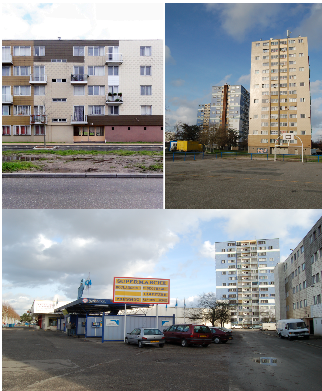
Figura II-37: Imágenes del estado de Yves Farge previo al inicio de las obras de la Operación de Renovación Urbana en 2004. Fuente: Bertrand Renaudin (SAEMCIB).
