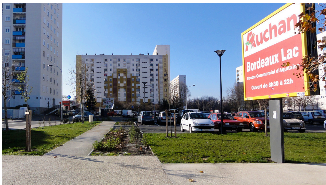
Figura II-22: Imagen del acceso peatonal a uno de los aparcamientos en superficie del grand ensemble Grand Parc de Burdeos. Fotografía tomada en diciembre de 2010 por a autora.
