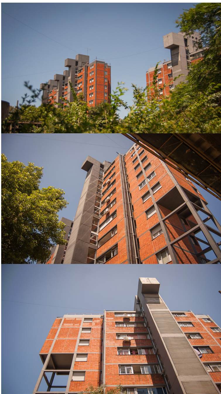
Figura II-33: Imágenes que muestran la impronta exterior del conjunto habitacional, compuesto por cuatro bloques lineales de "torres adosadas", unidas por los esbeltos volúmenes de las torres de ascensores. La volumetría decreciente hacia la base se debe a que las tipologías de plantas inferiores, de menor superficie, dejan libre parte de la malla estructural de hormigón armado, abriendo la posibilidad de su futuro crecimiento. Fuente: Fran y Fiorella Russo.
