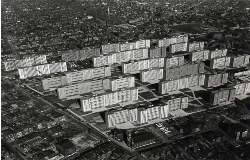
Figura II-19.: Vista aérea del complejo habitacional Pruitt-Igoe en Saint Louis, Missouri previa a su demolición (1972). Fuente: Carlos García Vázquez.
