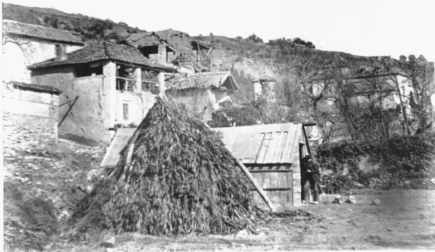
Albuñuelas, edificios en la C. del Lavador.
