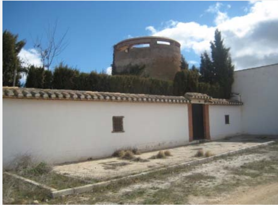
Figura 1. Estado del antiguo molino de viento (2012).
