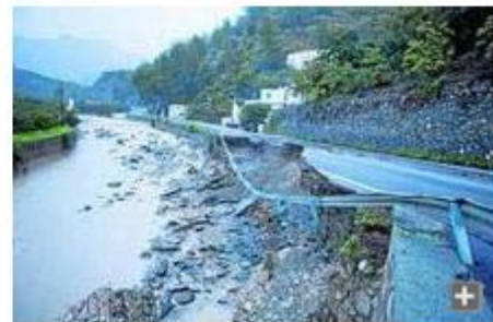
La carretera comarcal que une Jete con Almuñécar, cortada por la lluvia.
