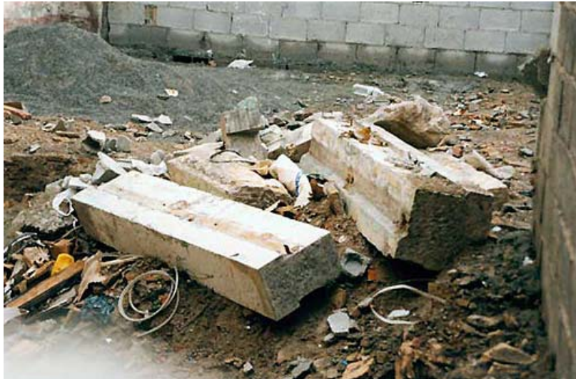
Ilustración 7. Objeto de demolición, en la calle Elvira (1999).
