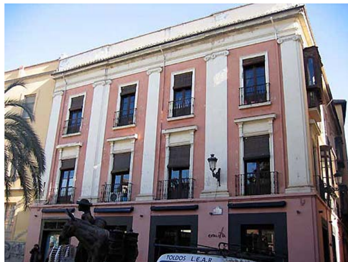
Ilustración 9. Edificio en Carcel Baja, esquina con Capuchinas.
