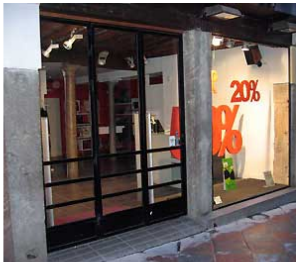
Ilustración 4. La pervivencia de la estructura de los alarifes, en la calle Zacatín (2008).
