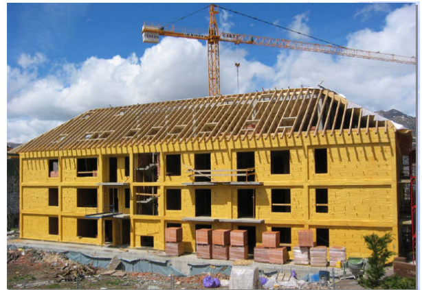
Fig. 85 Aplicación de PUR en edificación
