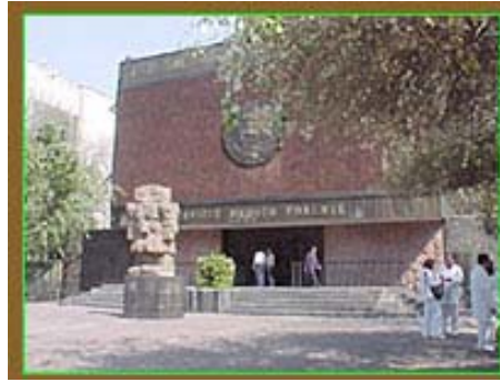
Figura N° 2: Fachada de la entrada del edificio del SEMEFO D.F.
