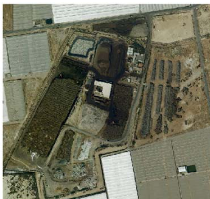
Figura I.6. Planta de compostaje de residuos vegetales de invernadero (El Ejido, Almería).
