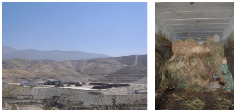
Figura I.7. Planta de compostaje de residuos vegetales de invernadero (Motril, Granada).
