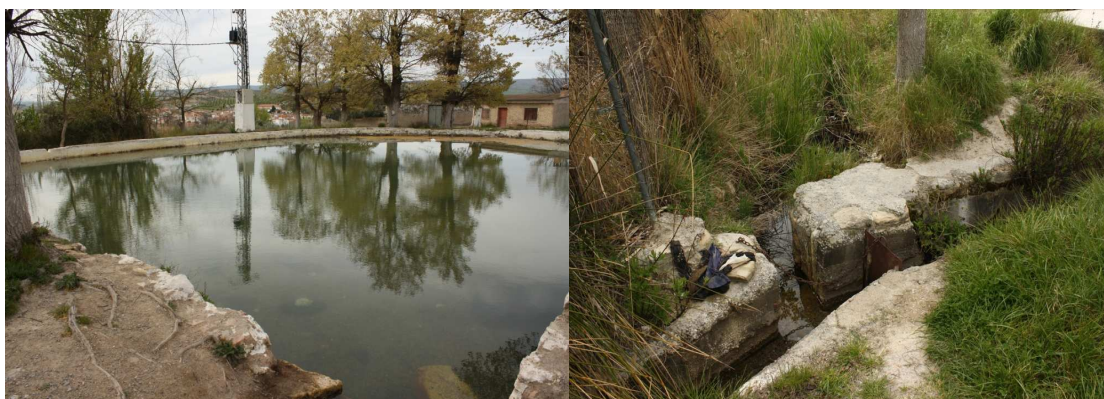
Figuras 18 y 19: Fotografía de detalle de la alberca del Baño en La Malaha y la acequia con partidor que deriva de ella.
