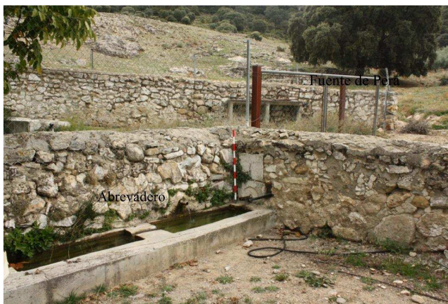
Figura 100: Fotografía con la situación del abrevadero con respecto a la Fuente de Pera.
