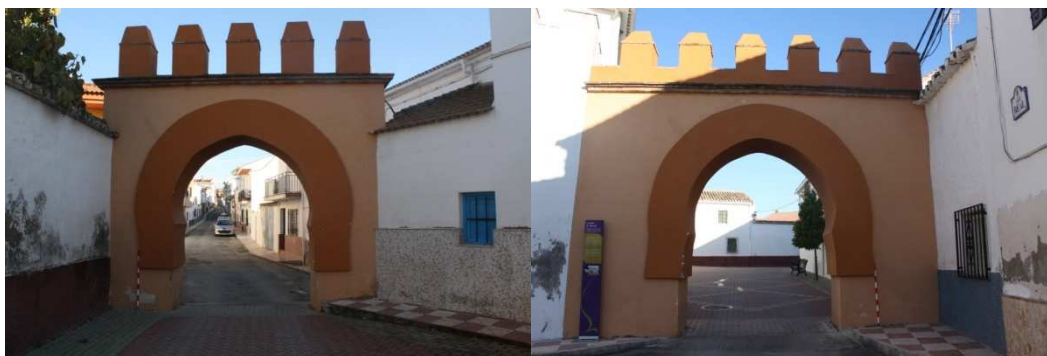
Figuras 43 y 44: Detalle de las dos puertas del castillo de Tajarja completamente restauradas.
