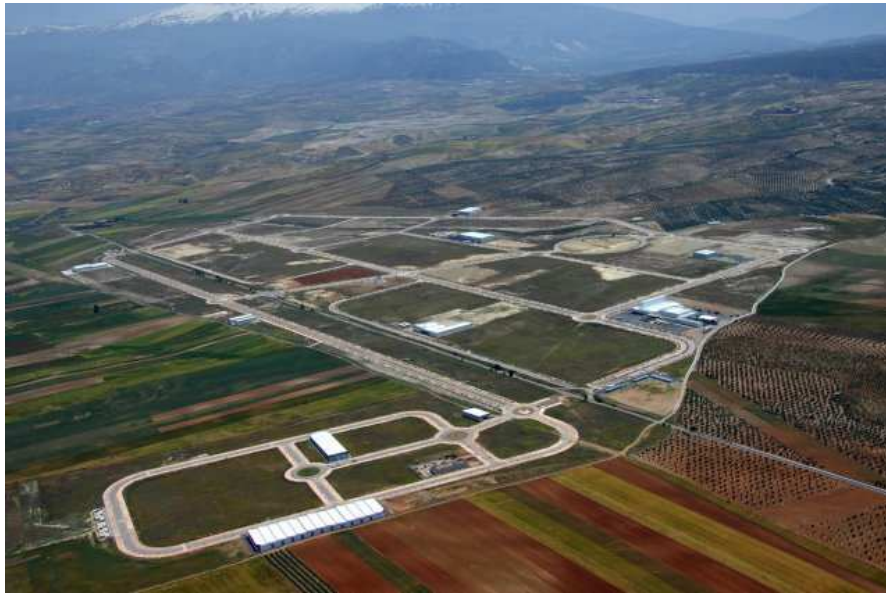
Figura 26: Fotografía aérea donde podemos ver la planta del Parque Metropolitano Industrial y Tecnológico situado en las inmediaciones de Escúzar. (Fuente: web del Parque 227 ).
