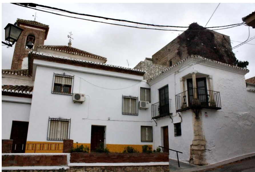
Figura 29: Fotografía de la torre alquería de Escúzar integrada en el conjunto edilicio conocido como «Casa Grande».
