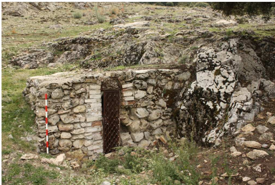
Figura 83: Fotografía de la fuente de agua situada en Alquería de Pera.
