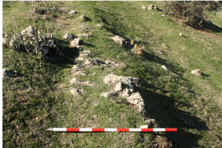
Figura 110: Fotografía de detalle de los restos de una estructura en la zona 2 de Alquería de Pera.
