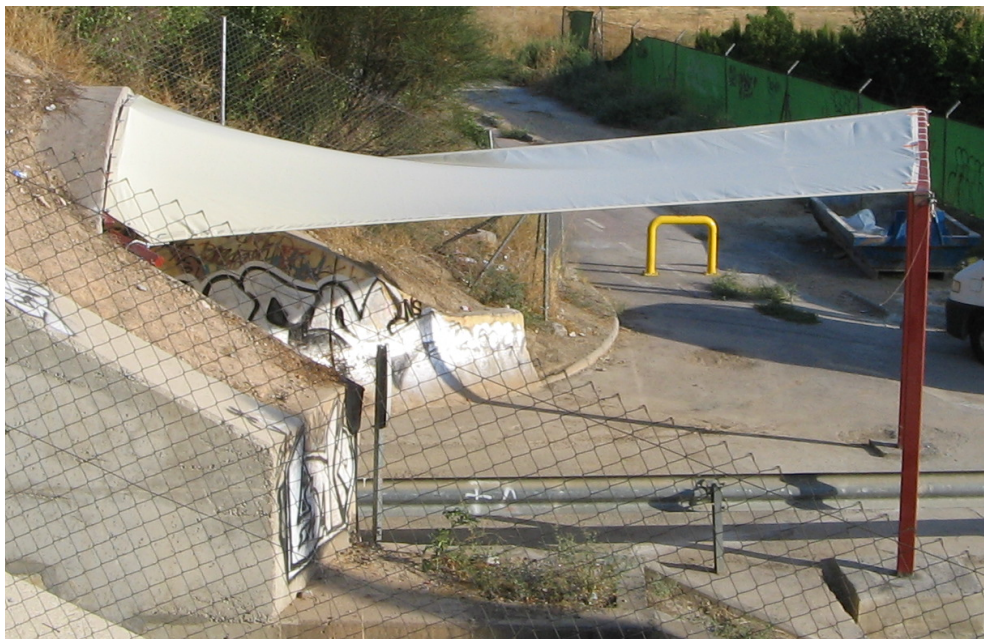
Figura 1. Estructura tensada en la entrada de un paso subterráneo.
