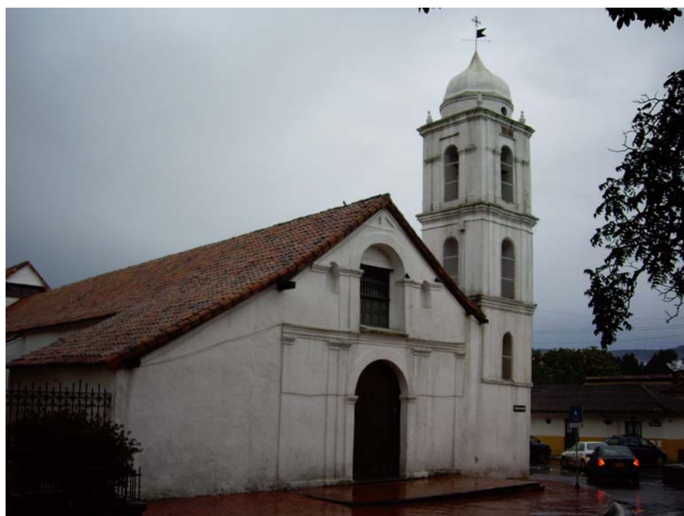
IGLESIA DE TENJO. FACHADA PRINCIPAL.
