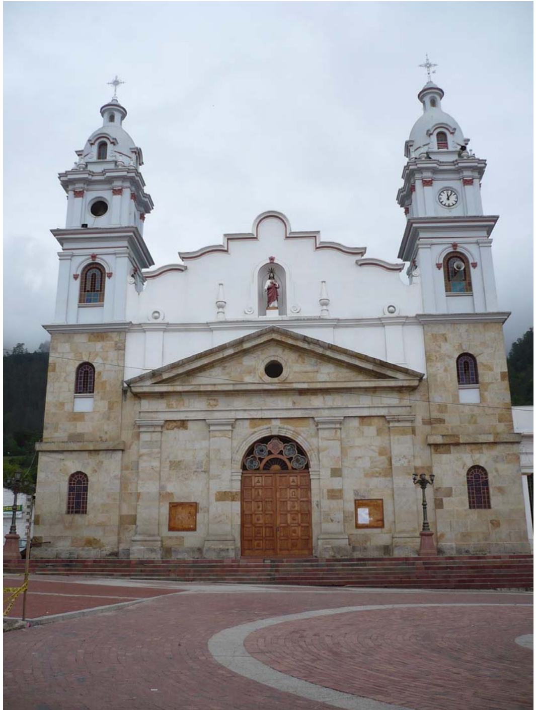
IGLESIA DE CHOACHÍ. EXTERIOR.
