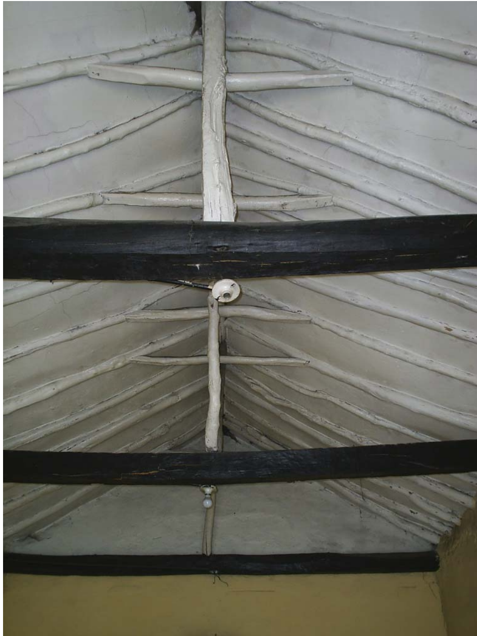
TÓPAGA. INTERIOR DE LA CAPILLA POSA.
