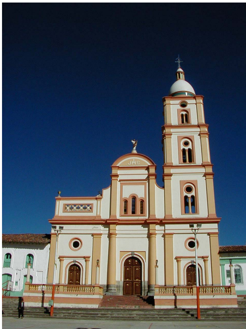
IGLESIA DE COCUY 614 . FACHADA.
