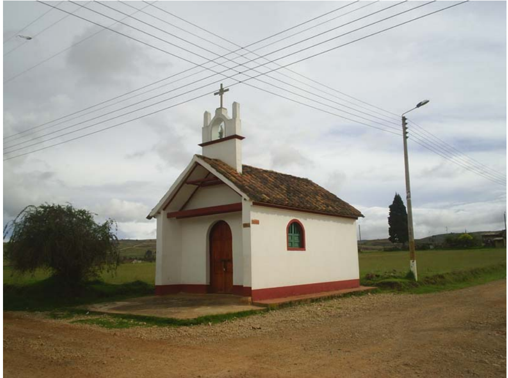
CAPILLA DE OICATÁ. EXTERIOR.
