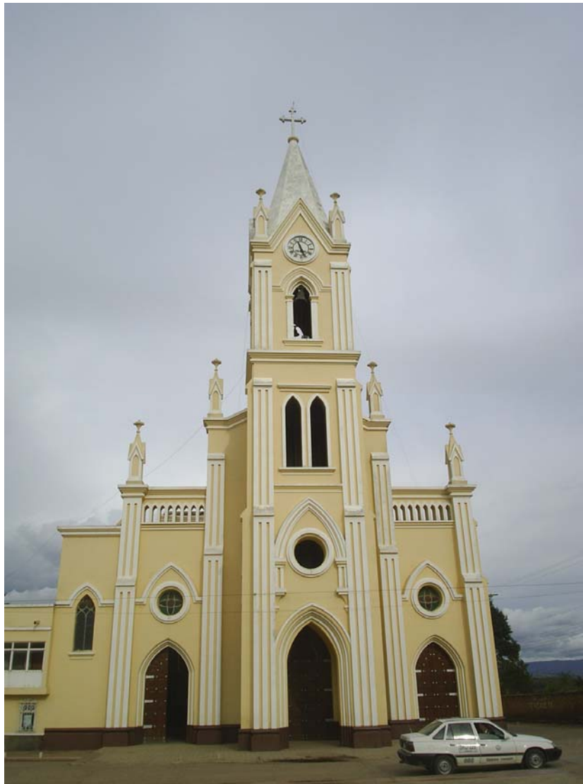
IGLESIA DE COMBITA. EXTERIOR.
