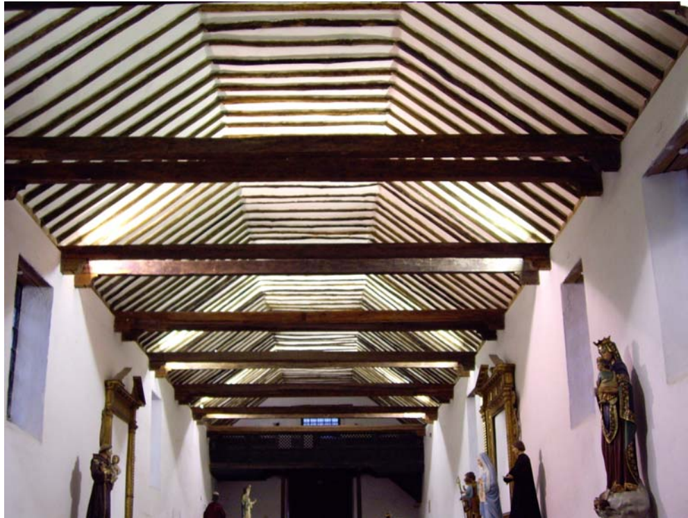
IGLESIA DE TENJO. INTERIOR. VISTA HACIA EL CORO.
