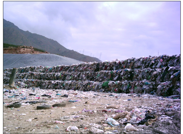
Figura 4.7: Vertedero de alta densidad en balas de Casares (Málaga). Fuente: Inmaculada López Gea.
