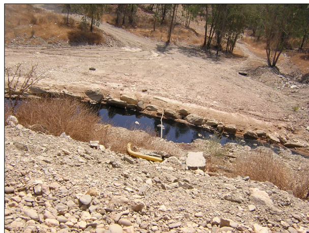
Figura 4.9: Fugas de la balsa de lixiviados. Planta de tratamiento de RSU de Villarrasa (Huelva). Elaboración propia.
