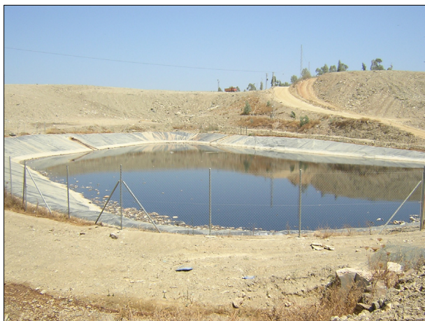
Figura 4.8: Balsa de lixiviados. Planta de tratamiento de RSU de Villarrasa (Huelva). Elaboración propia.
