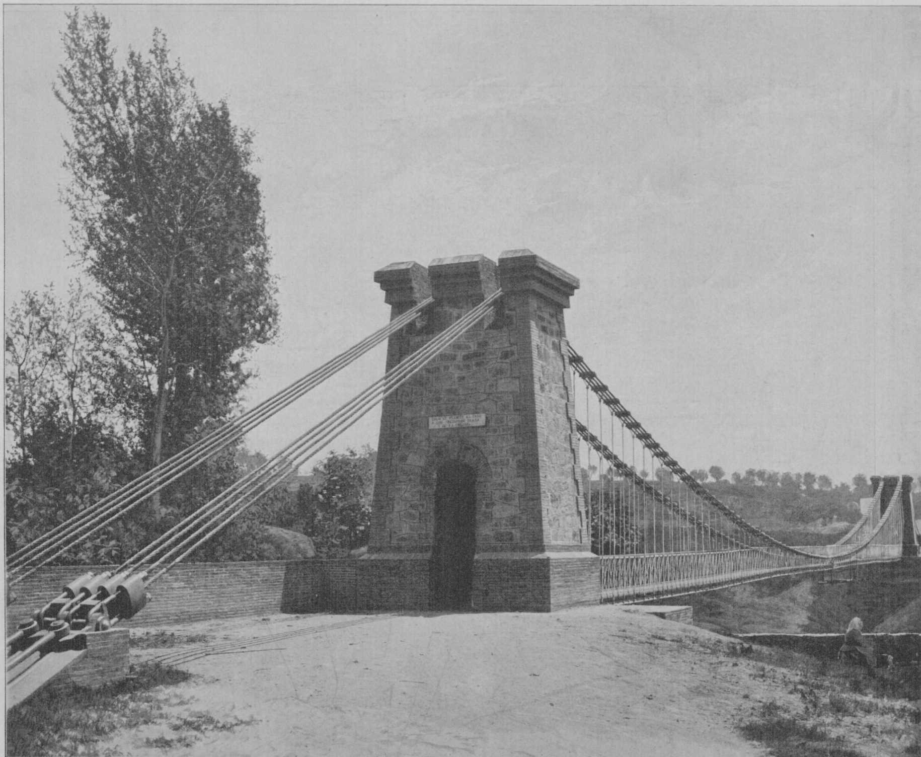
PUENTE DE ENTRADA A LA COLONIA SEDÓ (ESPARRAGUERA)
