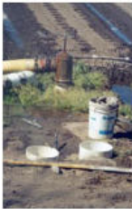
Detalle del sistema de riego por goteo
