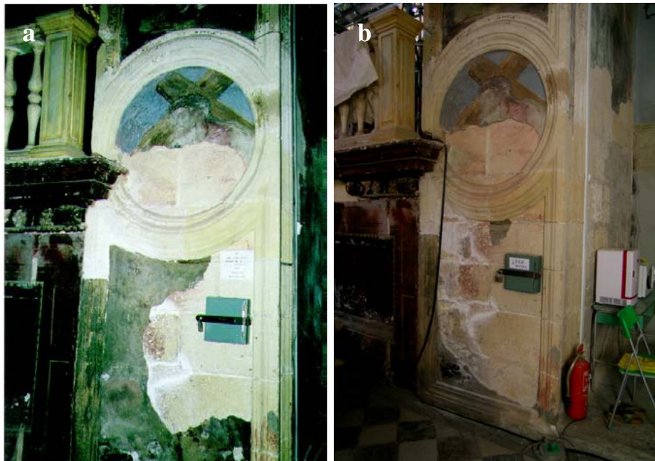
Figura 3.21. Evolución del daño en la zona muestreada: a) 1998 (Cardell) y b) 2004.
