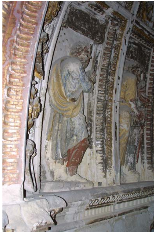
Figura 3.8. Pérdida de material de las esculturas del cuerpo superior de la Iglesia del Monasterio de San Jerónimo.
