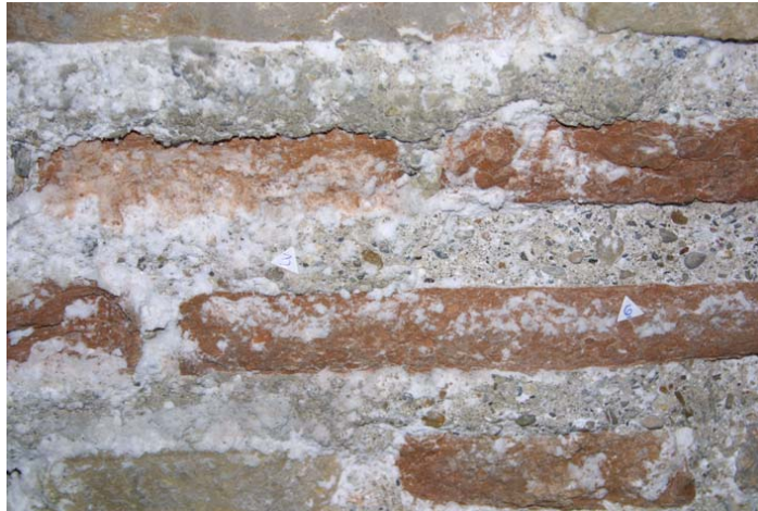
Figura 2.14. Eflorescencias salinas en los ladrillos de la Catedral de Granada. (Fecha del muestreo: Diciembre 2004)
