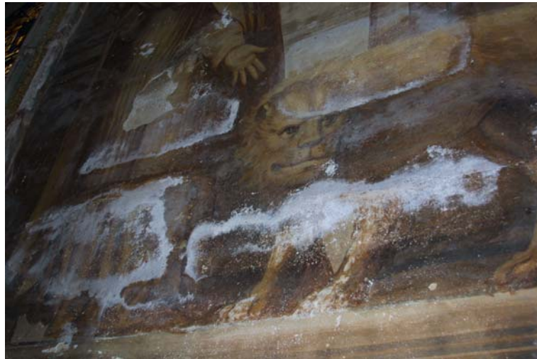
Figura 3.7. Eflorescencias en las pinturas murales del cuerpo superior de la Iglesia del Monasterio de San Jerónimo.
