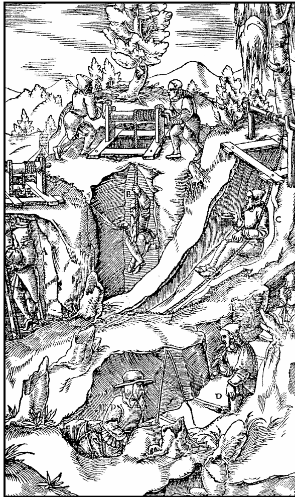
Fig. 421. Representación de como los mineros acceden al interior de las minas a través de los pozos (Agrícola, 1556)
