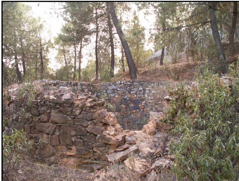
Fig. 416. (1 y 2) Pozos modernos del filón Ranchero con brocales contruidos en piedra (Est. 160) (El Centenillo, Jaén)
