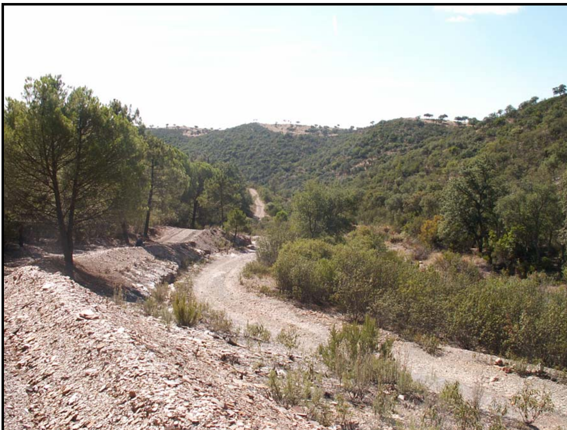
Fig. 247. Panorámica general del escorial-fundición Fuente Pilé (se distribuye a un lado y otro del camino) Est. 144-145
