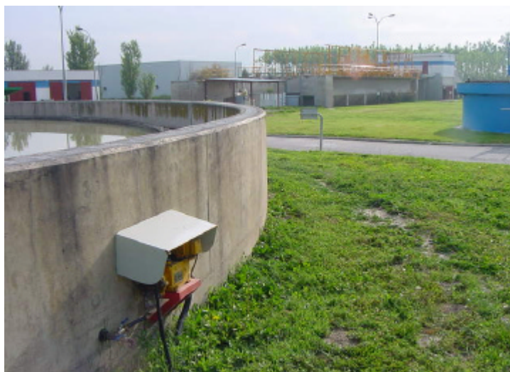
Figura 3.5. Decantador primario de la estación depuradora, donde se encuentra situada la membrana de impulsos.
