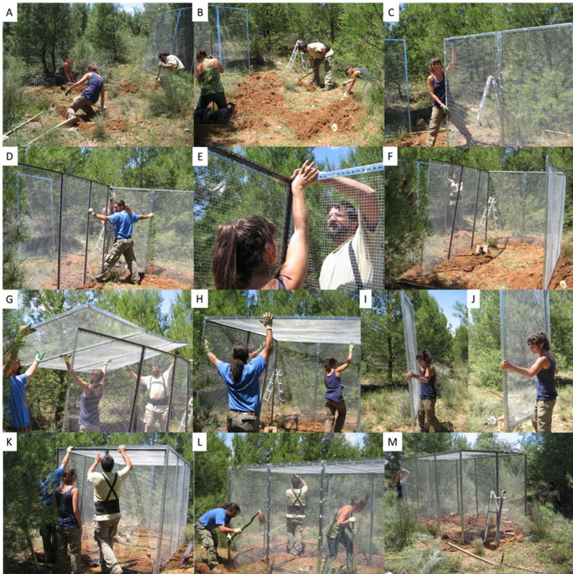
Figura 1. Proceso de montaje de una jaula individual de cría. (A) En primer lugar se excavaron las cuatro esquinas que servirán de pilares de anclaje. (B) A continuación, se excavó pequeños canales donde irían enterrados los paños laterales y del fondo. (C y D) Se colocaron los paños, (E) y se atornillaron entre ellos (F). (G) Se colocó el techo y (H) se atornilló. (I y J) se colocó el paño frontal con la puerta y (K) se atornilló al resto de la jaula. (L) Se acondiciono el interior ablandando el terreno y se enterraron los laterales. (M) Finalmente se ajustaron todos los tornillos. (Fotografías cortesía de Juan M. Peralta-Sánchez).
