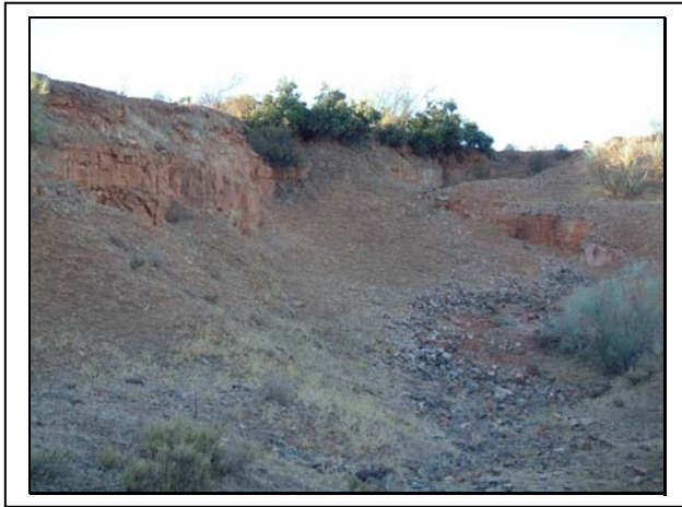
Fig. 151: Zona de aterrazamiento y escombrera de estériles y materiales no útiles en explotaciones a cielo abierto de canteras de pizarras en la zona de Corrales, Baños de la Encina.
