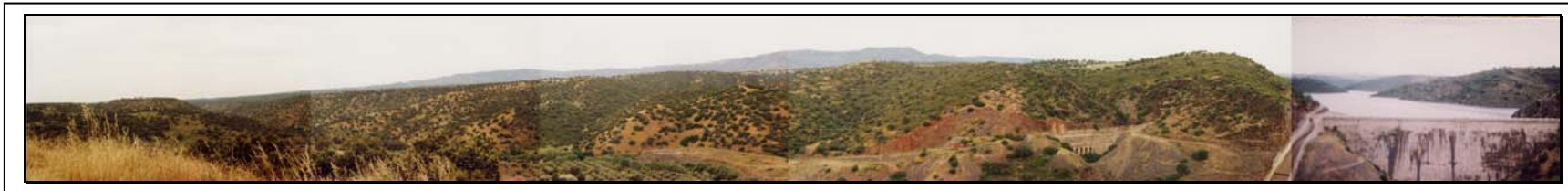
Fig. 135: Fotomontaje de dirección noreste – suroeste realizado en la presa del embalse del río Rumblar. basculamiento hacia de los cerros de basamentos pizarrosos y la aparición de diques pegmatíticos muy alterados generando profundos saprofitos de arcillas muy ferruginosas.
