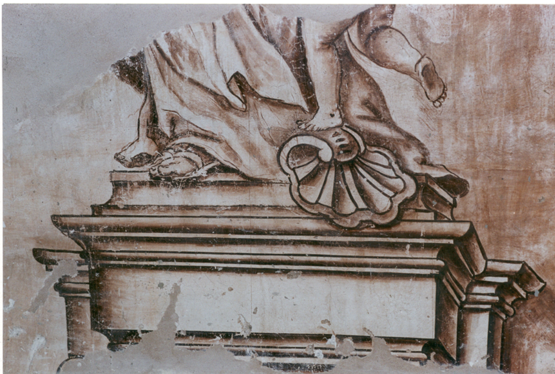
Ilustración 03. Detalle del fragmento conservado de la fachada de la iglesia de los Santos Mártires San Ciriaco y Santa Paula de Málaga. Fotografía del autor.
