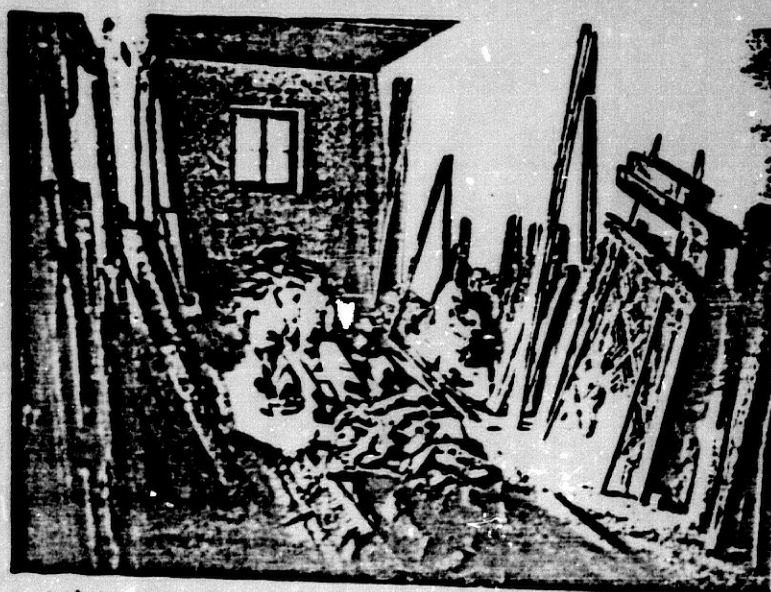
Almacén de madera en el pasillo sobre los baños .
