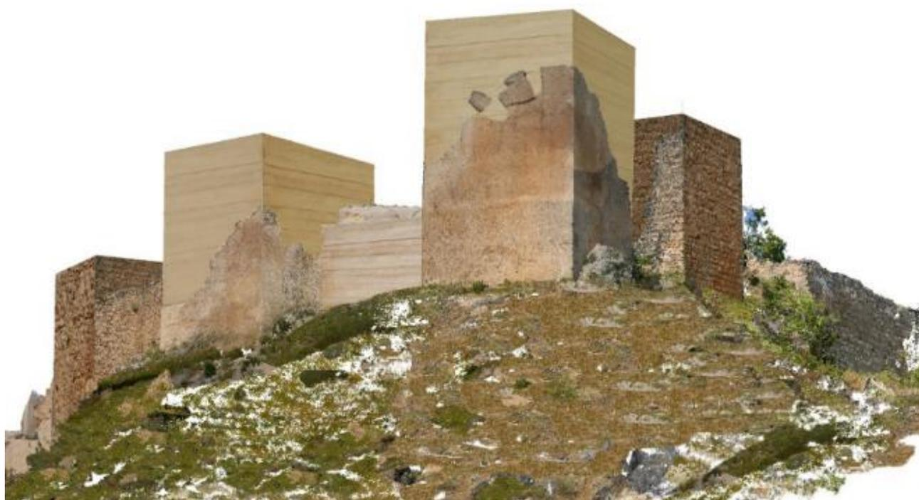
**Figura 28:** Infografía de hipótesis de reconstrucción de las torres 1, 2, 10 y 11 en diferentes materiales.
