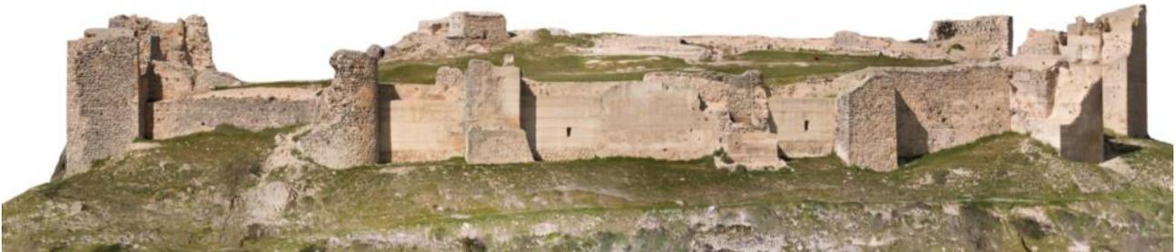
**Figura 14:** Ortofotografía del alzado sur del castillo, obtenida a partir del MDS.
