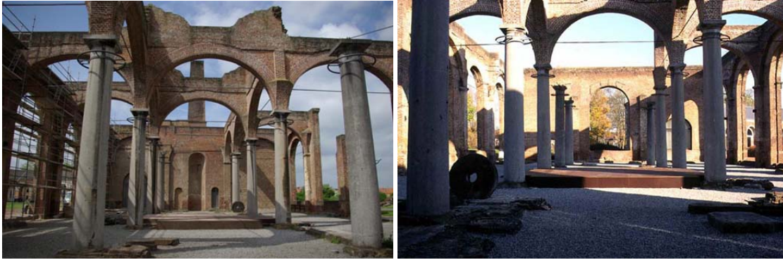
Interior del Taller de máquinas del Grand Hornu, Bélgica. A modo de gran sala hipóstila de carácter basilical es uno de los ejemplos más significativos de construcción industrial del país.
