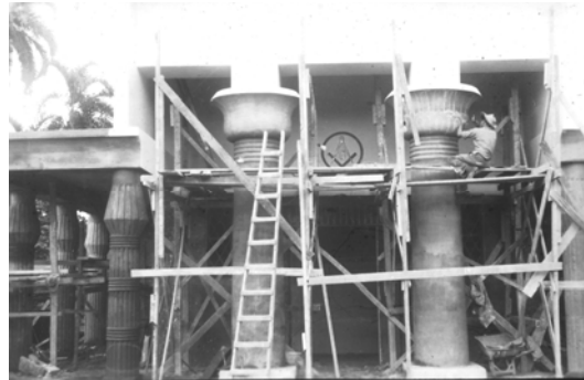
Fotografías de la construcción de la logia Torrealba, núm. 13. c. 1951, Costa Rica. Archivo Hermandad Obrerón Loria. Costa Rica. Las columnas J y B del Templo son erigidas antes del término de todo el conjunto ya que en ellas radica el valor simbólico de la logia en construcción –levantar columnas–. La adopción estética del neogipcio en fachada, en este caso está asociada al templo rosacruciano iniciado en 1927.
