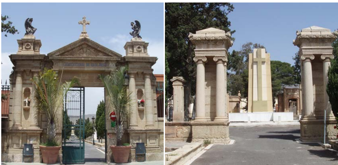
Portadas del Cementerio de San José, Almería. Cerramiento exterior –imagen izquierda– y cerramiento interior del perímetro noble –imagen derecha– Trinidad Cuartara Cassinello (1877).
