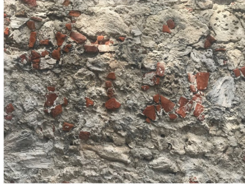
Imagen 1. A) Muro de piedra y argamasa de cal, B) Muro de pedazos de ladrillo, piedra y coral triturado
