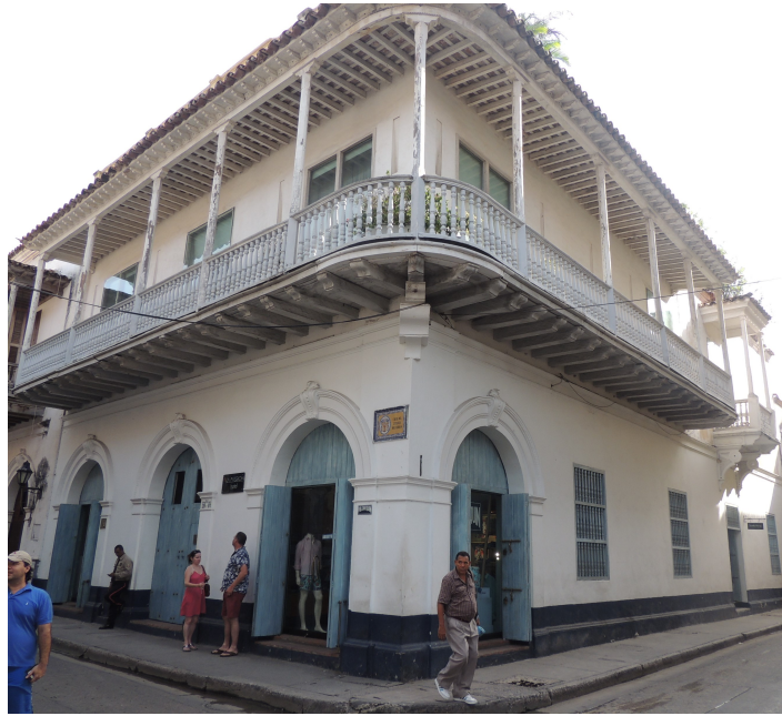
Apéndice xi: Casa Colonial Alta con balcón cubierto de esquina de cinco módulos en cada cara, portadas rinconadas grandes, ventanas de reja.
