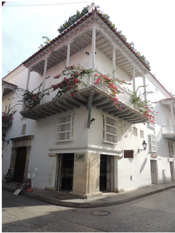
Apéndice ix: Casa Colonial Alta con balcón cubierto de esquina de tres módulos en cada cara, portadas rinconadas pequeñas, ventanas de reja y portada mediana.
