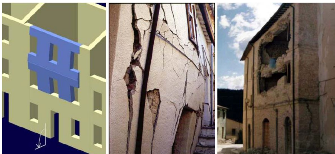
Figura 44. Mecanismo de flexión vertical (Foto: MEDEA – Papa e Zuccaro, 2001)
