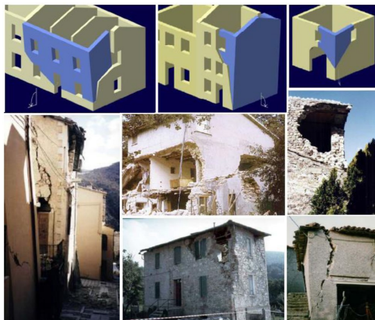
Figura 42. Mecanismo de inclinación compuesto (Foto: MEDEA – Papa e Zuccaro, 2001)
