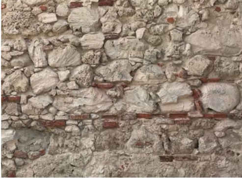
Imagen 1. A) Muro de piedra y argamasa de cal, B) Muro de pedazos de ladrillo, piedra y coral triturado
