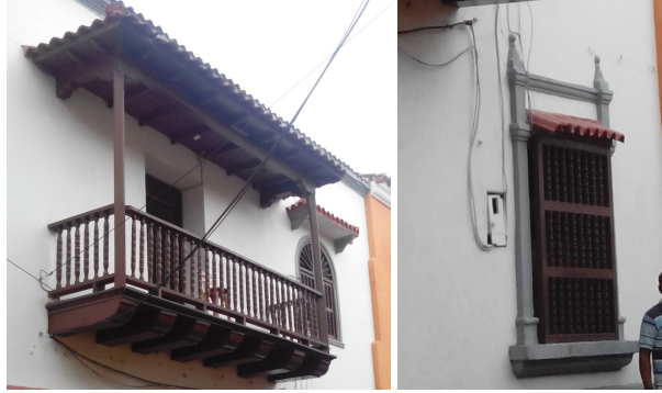
Apéndice cii: Cornisas y parapetos de la edificación.
