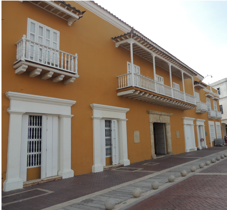
Apéndice vi: Casa Colonial Alta con balcón cubierto de cuatro módulos, balcón de tribuna y portadas grandes.
