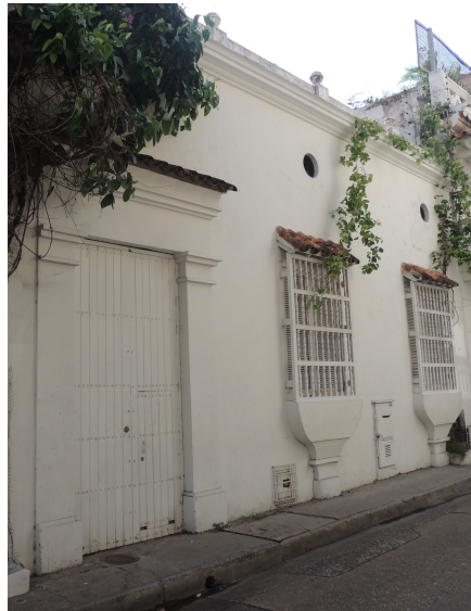
Apéndice ii: Casa Colonial Baja con ventanas de panza y portada mediana.
