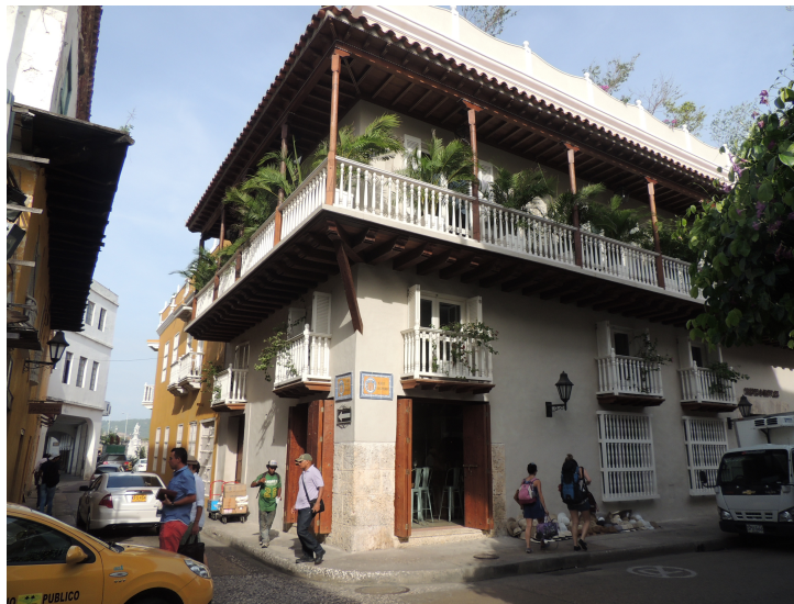
Apéndice x: Casa Colonial Alta con balcón cubierto de esquina de cuatro módulos en cada cara, balcón de tribuna, portadas rinconadas pequeñas y ventanas de reja.
