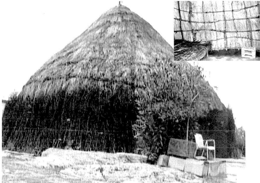
Fig. a.5 – Antigua fotografía de 'bujío' o chozo típico de Extremadura realizado mediante entramado vegetal y detalle del interior (arriba derecha) donde pueden observarse los postes laterales que soportan la estructura y los entrecruzamientos horizontales (Januvec 2008).
