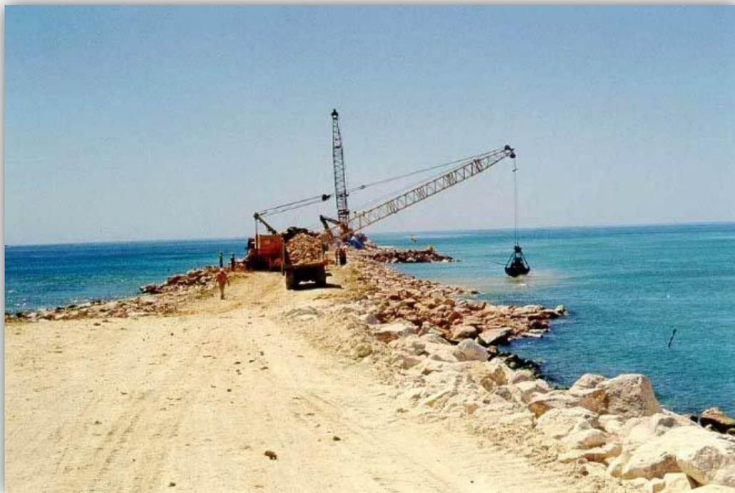
*Figura 30. Proceso de ejecución de los mantos desde el propio dique mediante grúa – ‘Grúas Aguado’*
