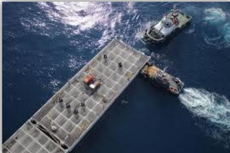
Figura 24. Maniobra de fondeo de los cajones de un dique vertical – ‘DOVICAIM’
