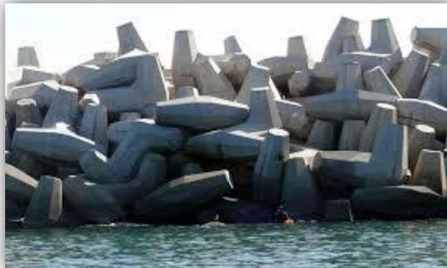
*Figura 23. Piezas de hormigón en forma de dolo para diques en talud – ‘Universidad Politécnica de Valencia’*
