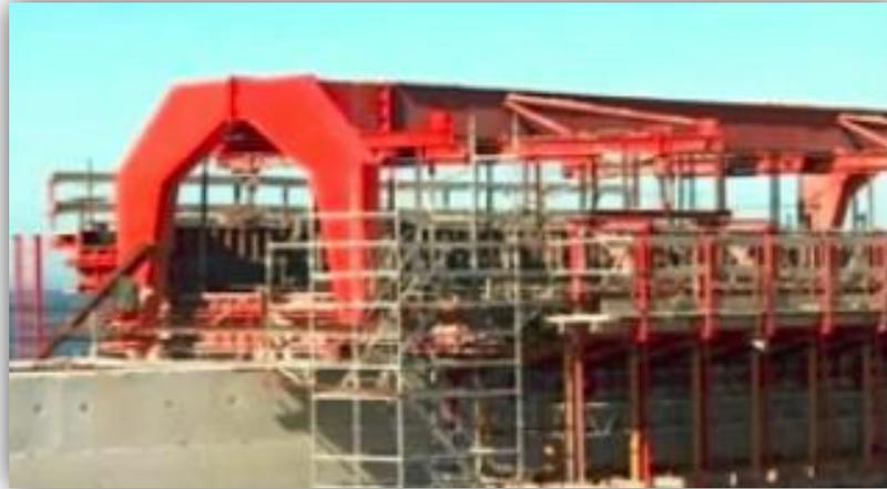
*Figura 31. Proceso de ejecución del encofrado de la losa – ‘Pipo Agu’*
