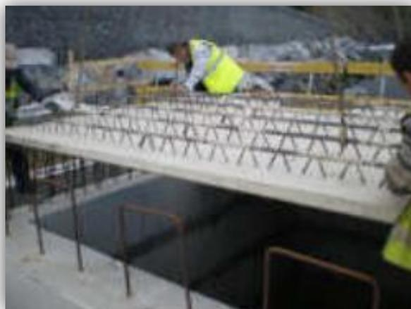
*Figura 35. Tapado de las celdas con losas prefabricadas – ‘Caminos País Vasco’*
