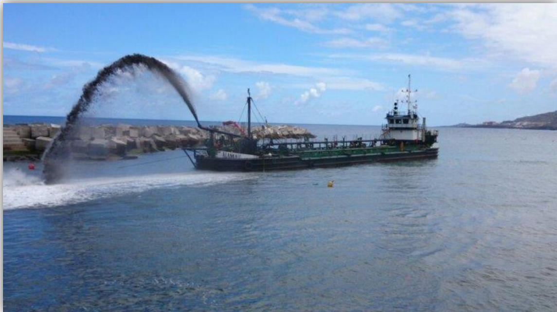
*Figura 28. Proceso de dragado mediante una draga-gánguil – ‘Drag-Sur’*
