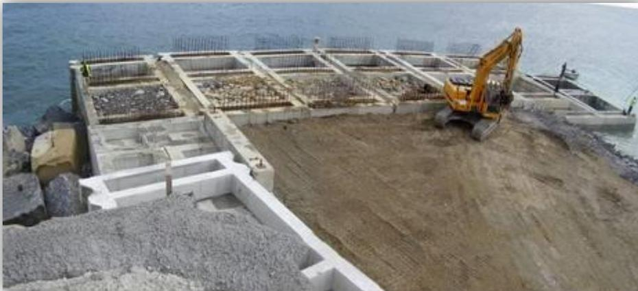
*Figura 34. Finalización de la plataforma de unión de las celdas con el dique – ‘Caminos Euskadi’*
