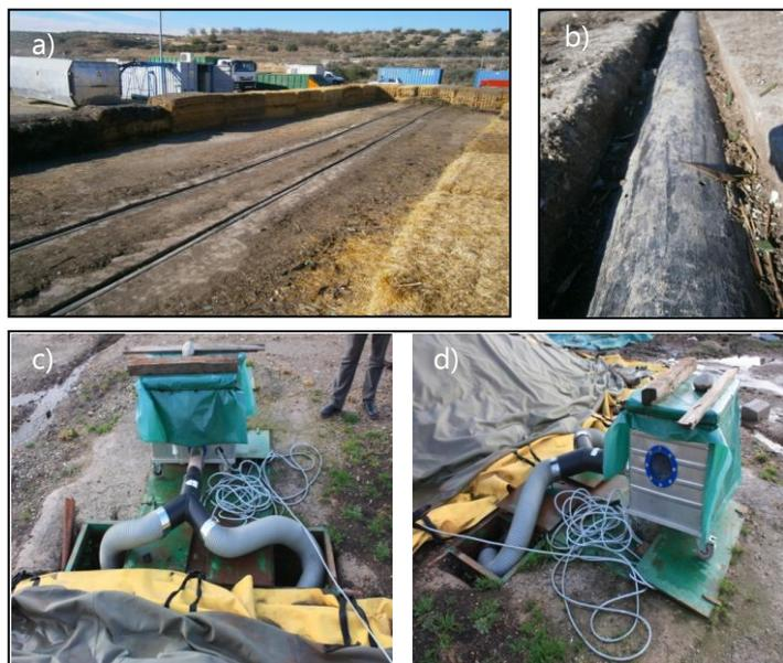
Figura 3.2. Conductos de aireación en el suelo a). Ampliación de la tubería b). Ventilador para suministrar aireación a la pila c). Conexión del ventilador a la pila d).
