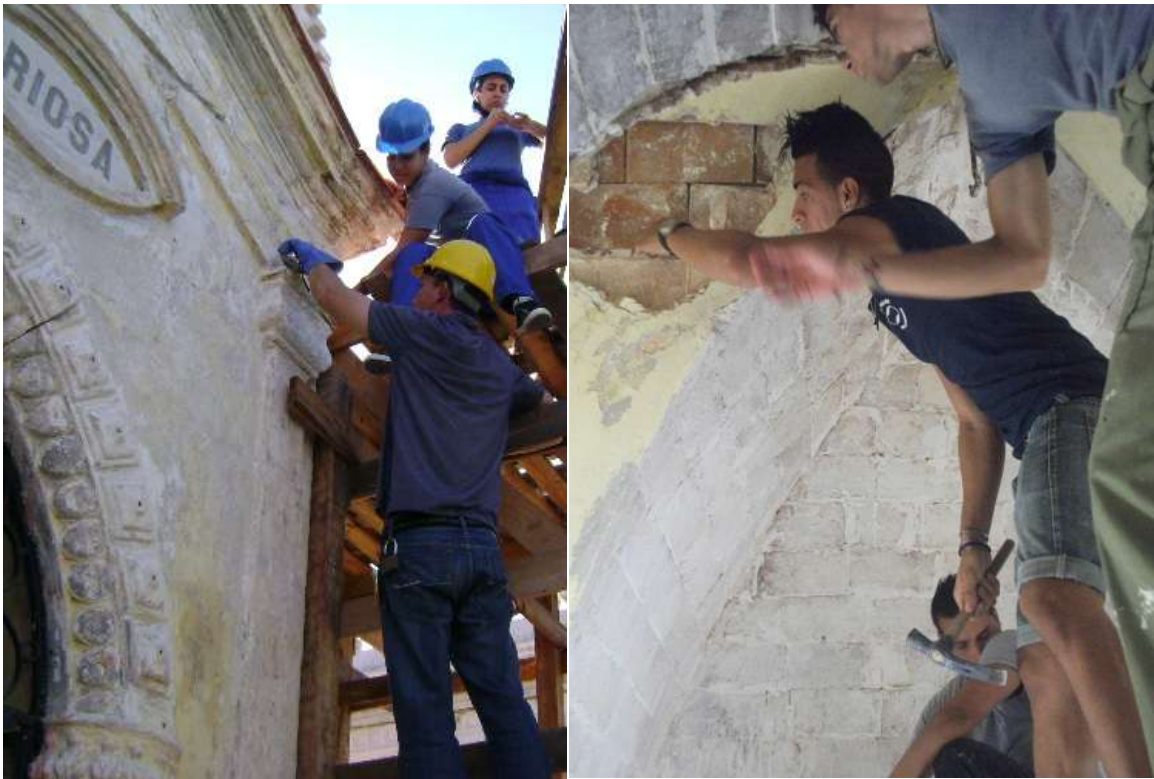
Fig. 164 Se trabajó en interiores y exteriores.
