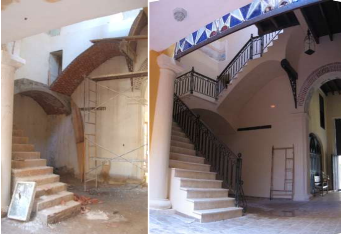
Fig. 139 Durante la ejecución de la escalera catalana y una vez concluida la misma.
