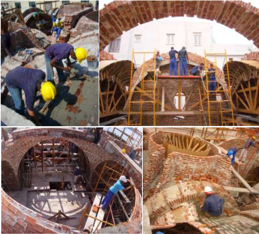
Fig. 132 Momentos de la construcción de las bóvedas en la iglesia.
