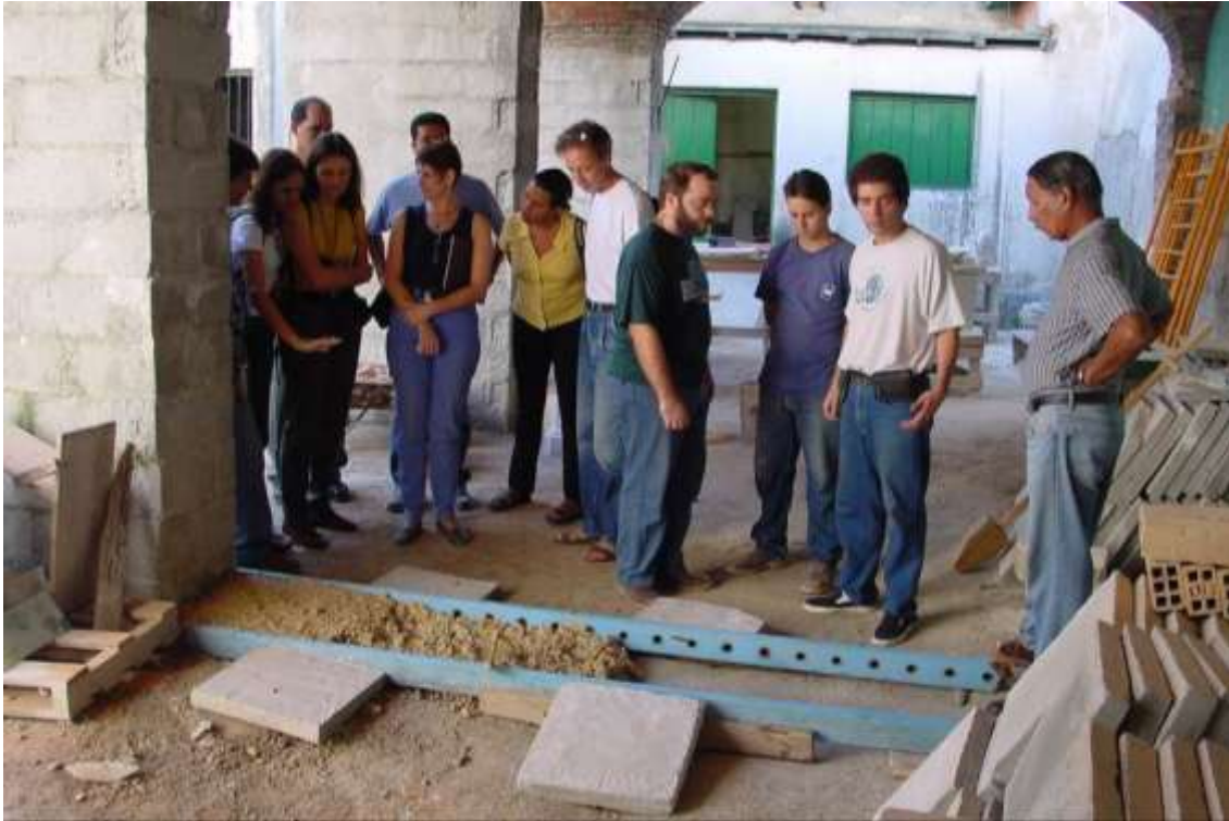
Especialistas suizos en el campo de la restauración comparten experiencias sobre la construcción de muros de tapial con alumnos y profesores del taller de cantería.
