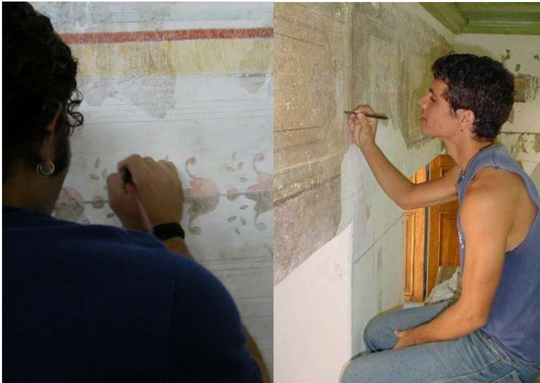
Trabajos de pintura mural en el restaurante Hanói y en la librería El Navío de la calle obispo.
