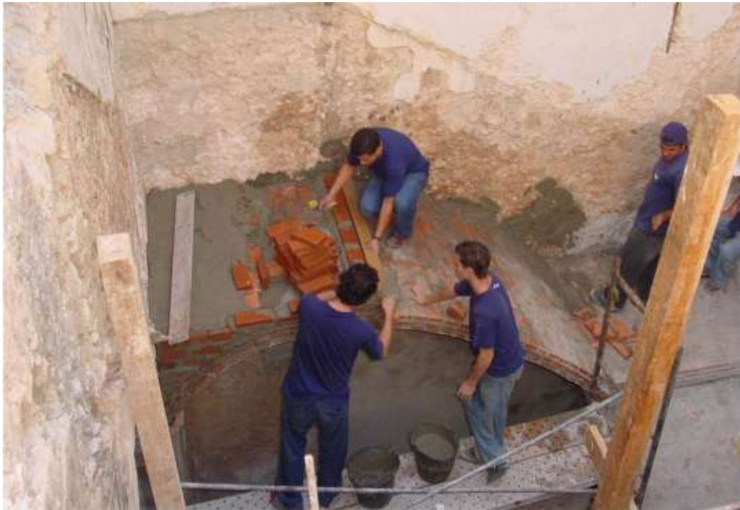
Construcción de escalera catalana en la casa Víctor Hugo.
