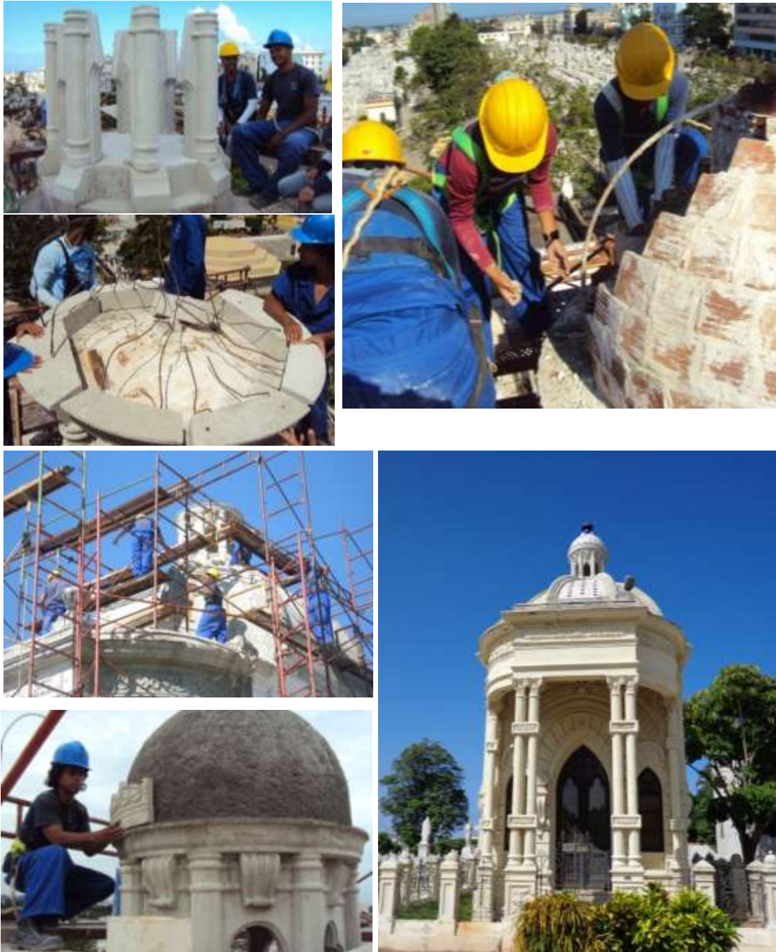
Fig. 152 Algunos momentos del trabajo en la Capilla Loredo en el Cementerio de Colón.
