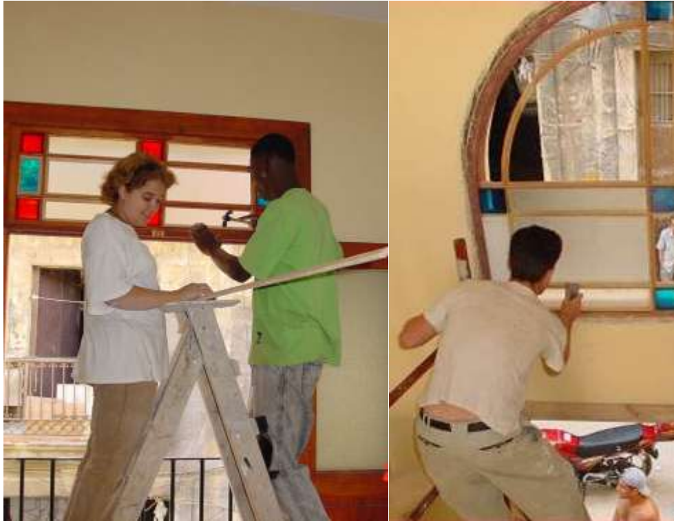
Trabajos de vidriería en residencias protegidas de la calle muralla. Los alumnos hicieron los vitrales en madera, y montaron y enmasillaron los vidrios multicolores en los mismos.
