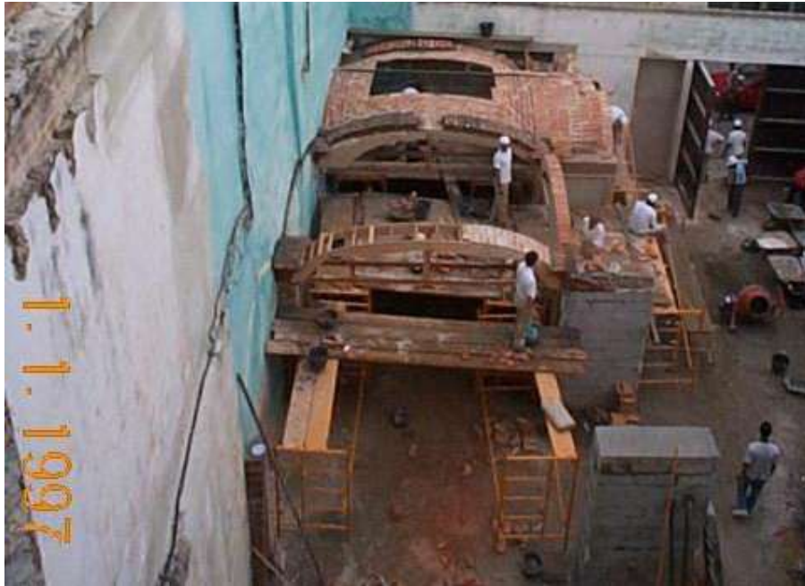
Albañiles trabajando de conjunto con alumnos de escuelas taller de España en la construcción de bóvedas extremeñas.
