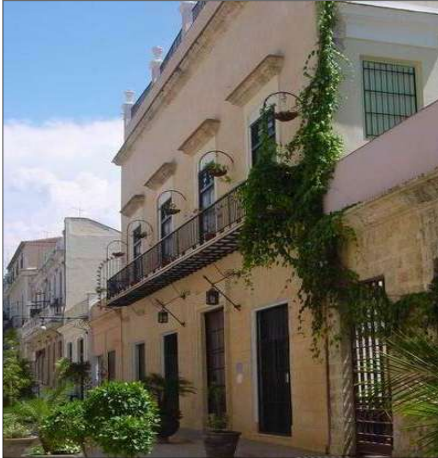
Fachada de Oficios 204.
