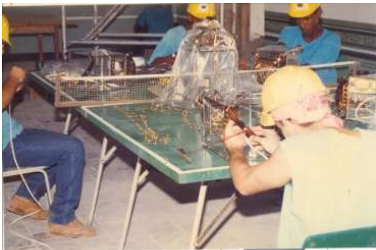
Electricistas laborando en el ensamblaje de luminarias para las galerías de Convento de San Francisco y en instalaciones eléctricas en el Claustro Sur del propio edificio.
