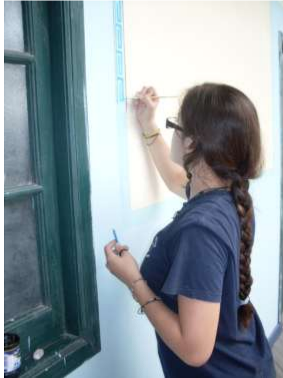
Trabajos de pintura mural en una casa de la calle Habana destinada a personas de la tercera edad.
