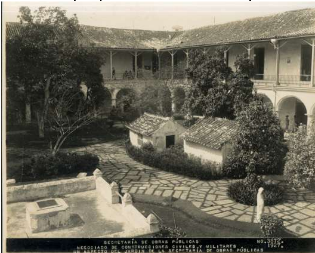
Fig. 9 Interior del Convento de Santa Clara de Asís, en la calle Cuba, una de las principales construcciones de esta etapa.
