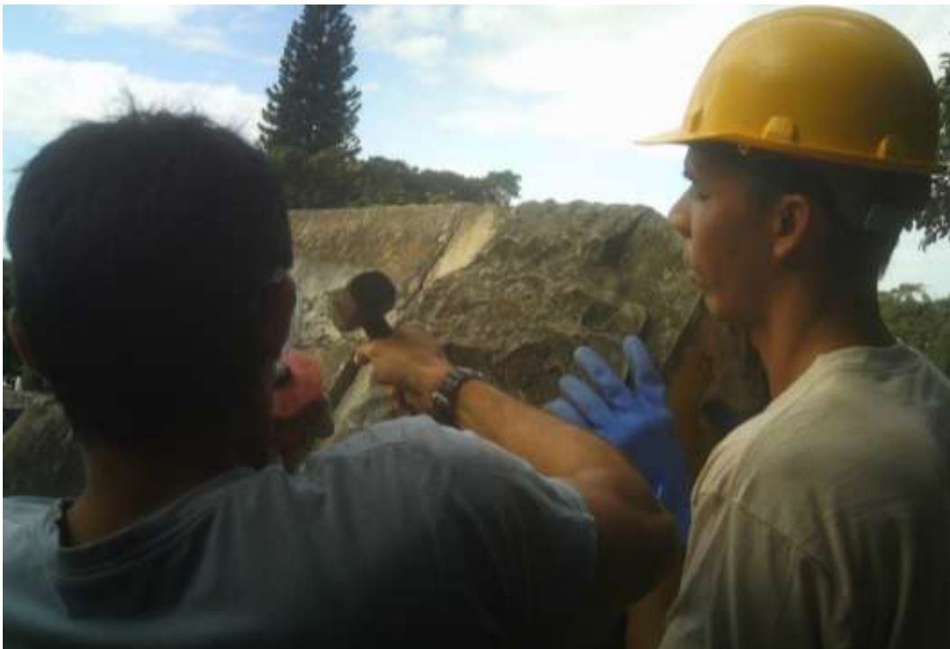
El profesor Alberto Chía, graduado de albañilería y actualmente Licenciado en Restauración del ISA, trabajando con un alumno en una de las capillas del Cementerio de Colón.
