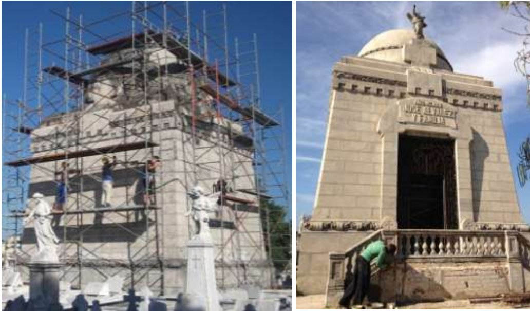
Fig. 156 Durante los trabajos y poco antes de concluirlos.
