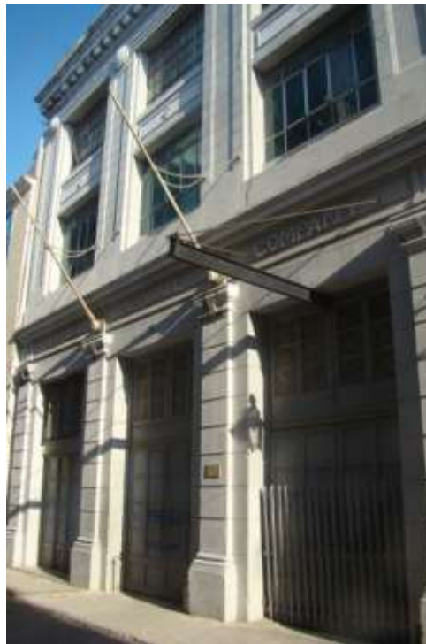
Edificio de Muralla 68.
