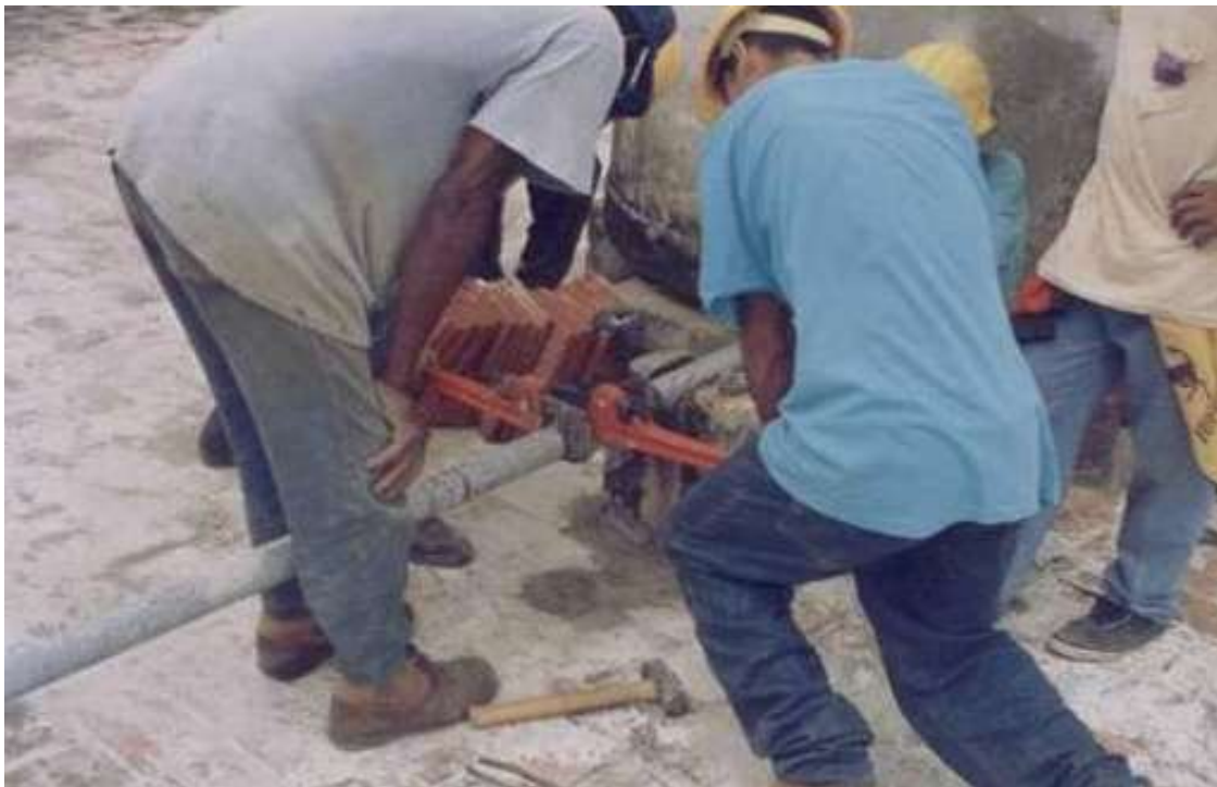
Alumnos trabajando en la plomería en el techo del Convento de San Francisco de Asís.
