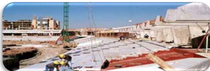
Obras de construcción del "Nuevo Los Cármenes"
