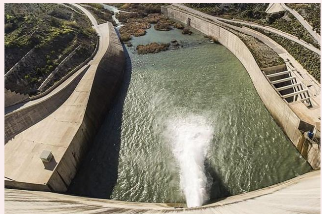
Embalse de Rules, con el hueco para la central a pie de presa (derecha).
