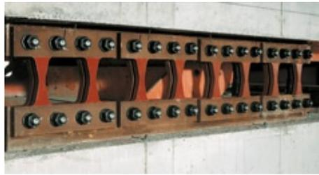
Figura 3.9. Disipador tipo HDS de la empresa *Kajima Corporation* instalado en muro de hormigón.
