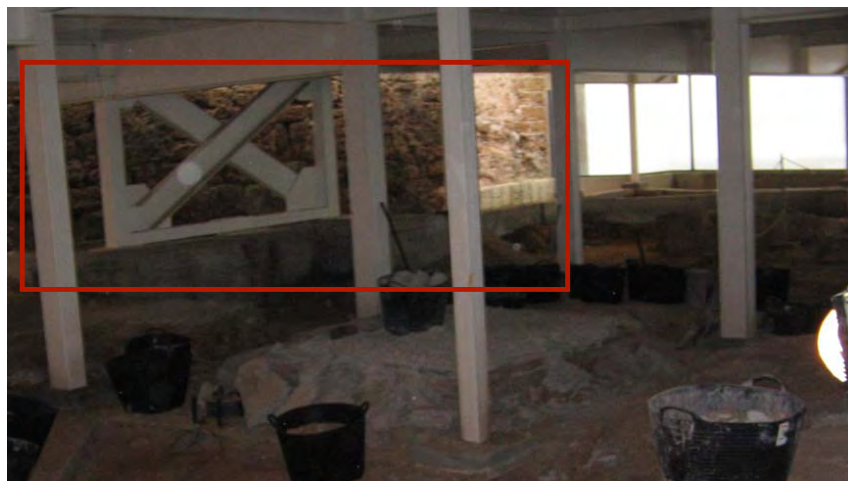
Fig. 458: Aspa estructural que impide la valorización del muro de época romana. (Foto: Julia García, 2015)
