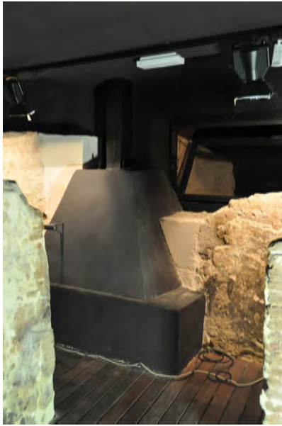
Fig. 548: Zapata peraltada entre la muralla del Alcázar. (Foto: Julia García, 2013)
