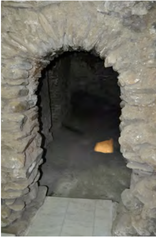
Fig. 432: Entrada desde el maslaj a la sala de agua fría. (Foto: Julia García, 2010)
