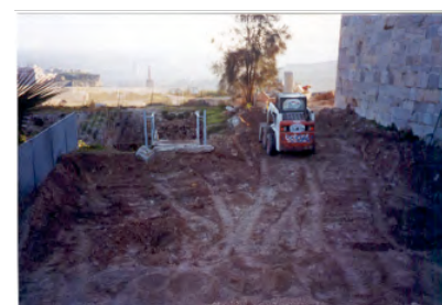
Fig. 360: Intervención arqueológica con el uso de una retro excavadora. (Martínez y Ortiz, 2002)
