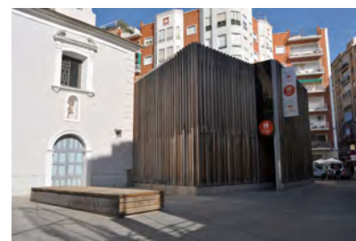
Fig. 385: Imagen del exterior del edificio. (Foto: Julia García, 2013)
