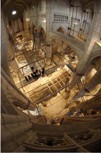
Fig. 701: Interior de la Catedral de Vitoria durante los trabajos durante los trabajos de arqueología y restauración en que desarrolla el programa “Abierto por obras”. ( http://calendariofinaldeltrabajo.blogspot.com.es )
