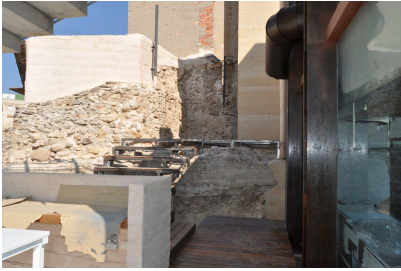
Fig. 329: Disposición de la escalera metálica de acceso al vacío de la torre y transformación del espacio en gastro-bar. (Foto: Julia García, 2014)
