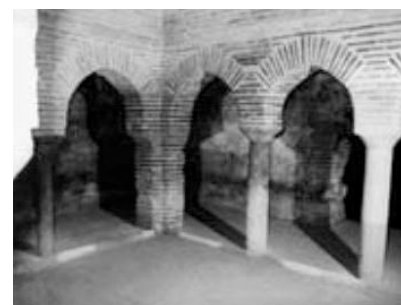
Fig. 398: Sala de agua templada tras la intervención de Prieto Cuéllar. (Bertrand, 2003)
