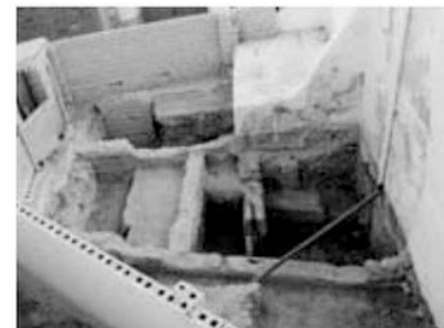
Fig. 403: Excavación del Maslaj . (Ibáñez, 2010)
