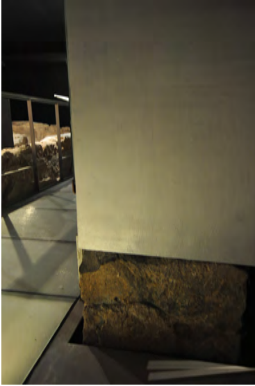
Fig. 510 y 511: Sistema de apoyo de los muros de cierre contemporáneos con las estructuras arqueológicas. (Foto: Julia García, 2015)
