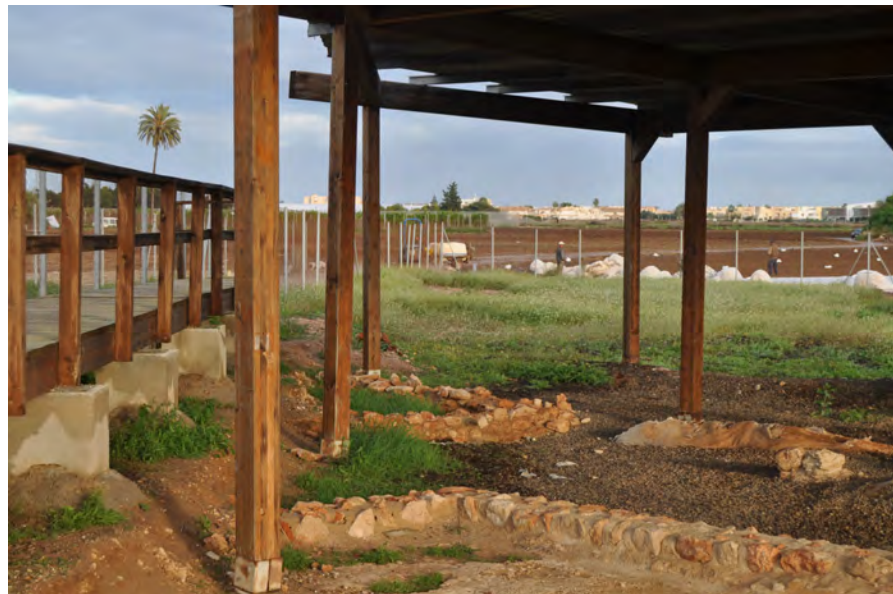
Fig. 282: Vista de los apoyos de la cubierta y apoyos de la pasarela. (Foto: Julia García, 2014)
