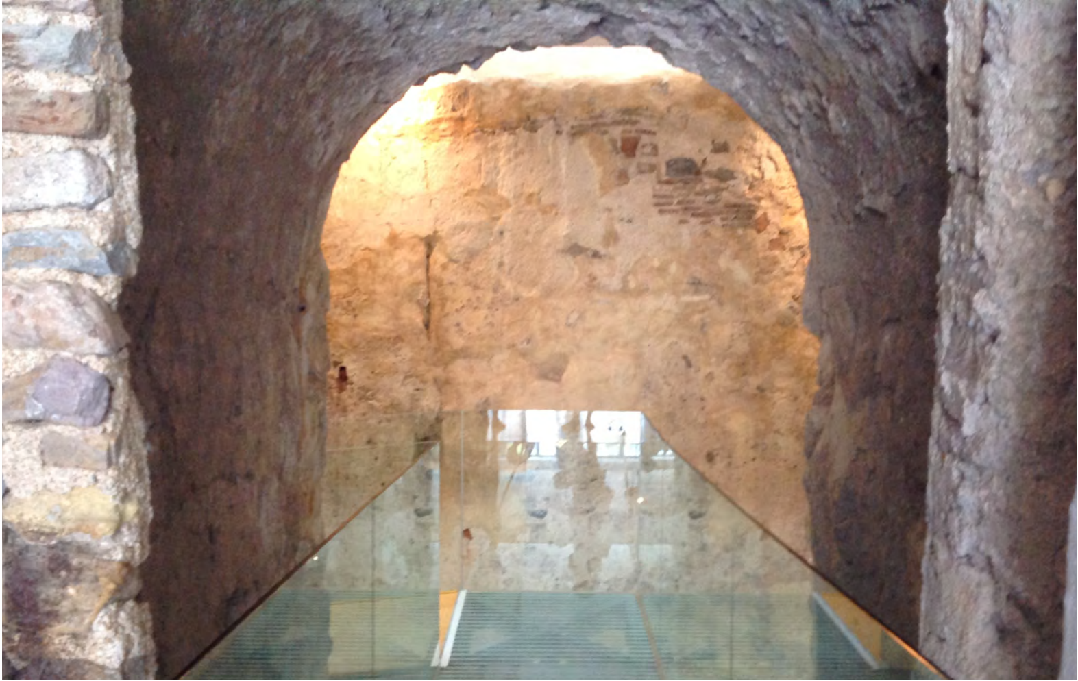
Fig. 357: Interior del Castillo de la Concepción. (Foto: Julia García, 2015)
