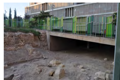
Fig. 628: Izq. Vista del edificio que acoge los restos conservados de la curia romana. (Julia García, 2015)
