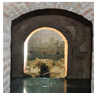
Fig. 397: Sala de agua caliente en la que se puede ver la caldera al fondo. (Foto: Julia García, 2013)
