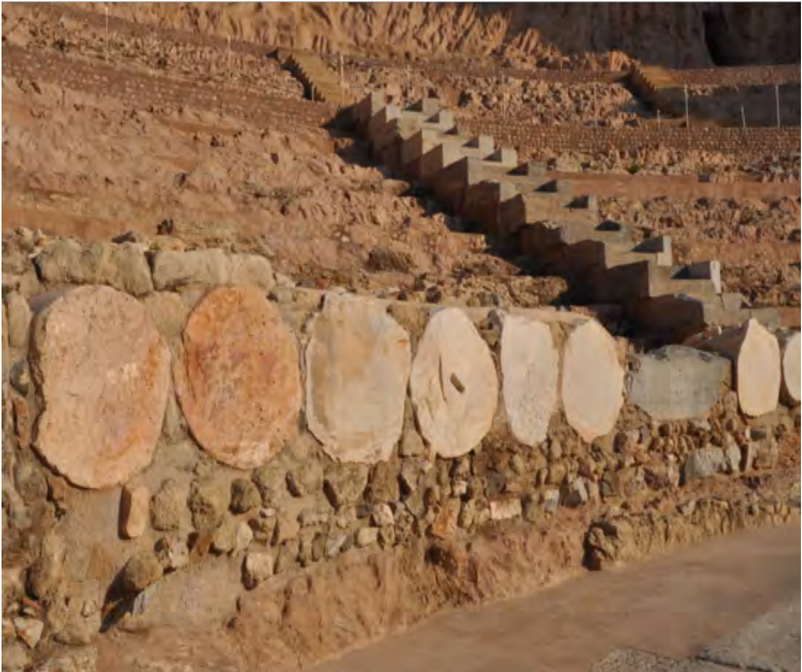
Fig. 100: Fotografía tomada desde la orbestra del Teatro de Cartagena. Vista de tambores de columnas reutilizadas para la construcción de muros. (Foto: Julia García, 2015)
