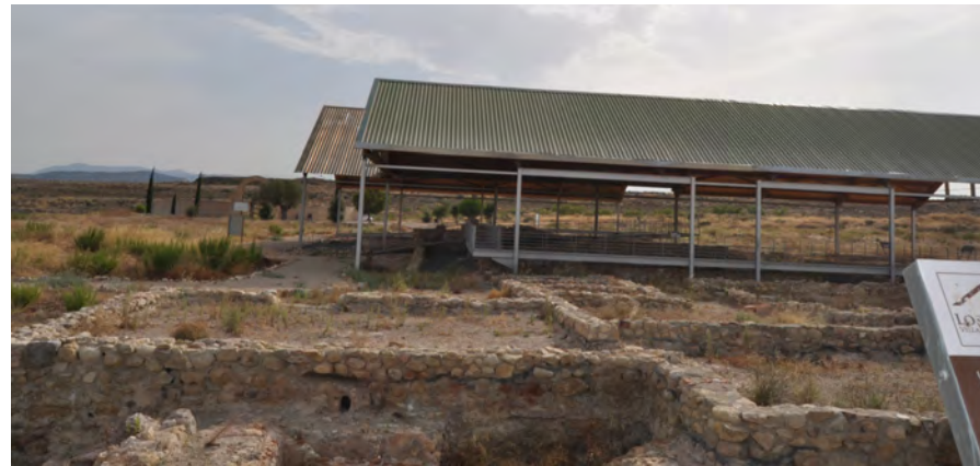
Fig. 259: Vista de la cubierta. (Foto: Julia García, 2014)
