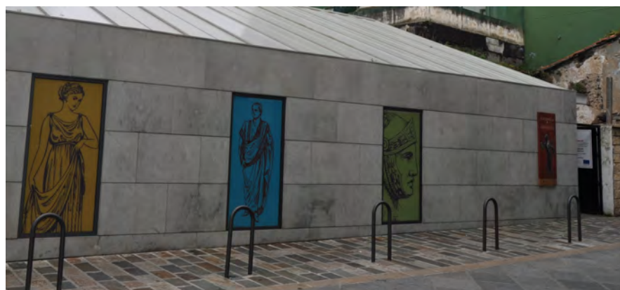
Fig. 704: Fachada de acceso a los vestigios de Flavióbriga. A la derecha, Puerta de entrada. (Foto: Julia García, 2012)
