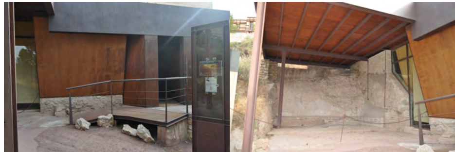
Fig. 145: Entrada al edificio de usos múltiples que apoya sobre estructuras arqueológicas dentro del espacio destinado a explicar el trabajo del arqueólogo. (Foto: Julia García, 2015)
