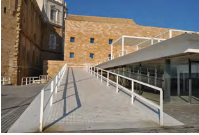
Fig. 448: Rama de acceso al mirador. (Foto: Julia García, 2015)
