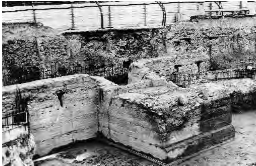
Fig. 483: Vista de la muralla y antemuralla tras la excavación. (Navarro y Ramírez,1996)
