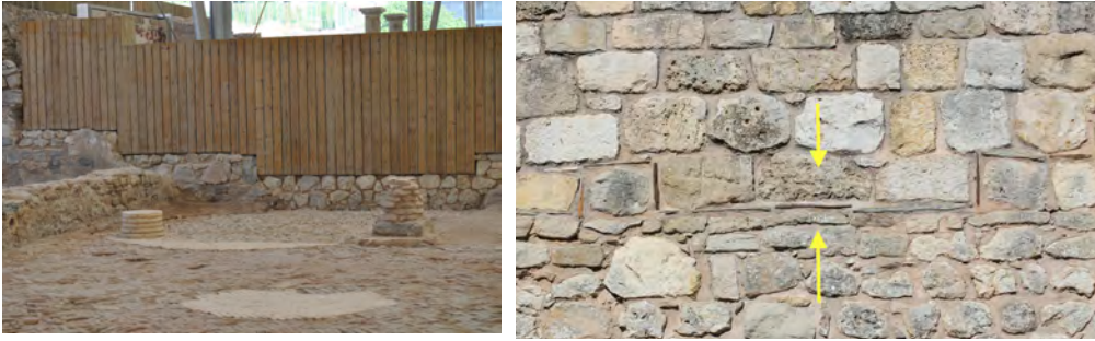
Fig. 82: Línea de diferenciación entre la estructura original y el recrecimiento. Castillo de Burgos. (Foto: Julia García, 2015)
