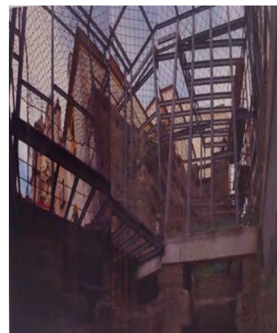
Fig. 377: Apoyo de la estructura contemporánea sobre las estructuras arqueológicas (AA;VV, 2007)
