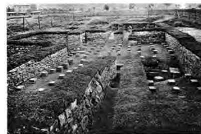
Fig. 656: Imagen de las termas romanas Biriciana de Weinsberg antes de situar la cubierta protectora. ( https://www.weissenburg.de/poi/romische_thermen_weissenburg1862/ )
