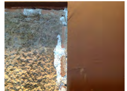
Fig. 363: Detalle de continuación del muro histórico con un muro de ladrillo revestido con paneles de acero corten. (Foto: Julia García, 2013)
