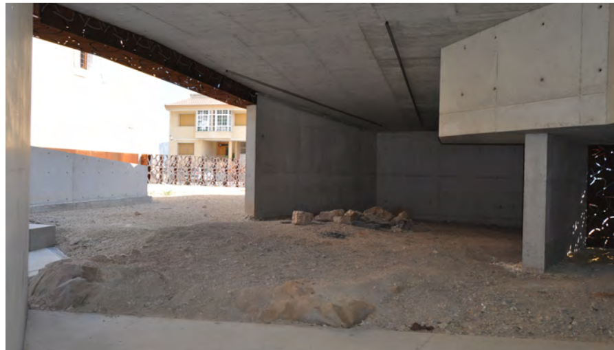
Fig. 190: Adecuación de estructuras halladas con motivo de la excavación realizada en 2008. (Foto: Julia García, 2013)
