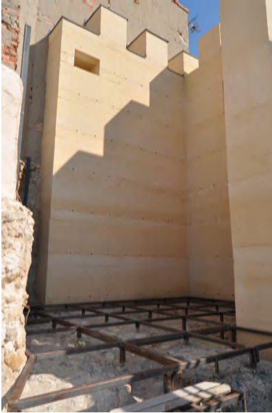
Fig. 332: Disposición de estructura acristalada con objeto de que el espacio se utilice como gastro-bar. (Foto: Julia García, 2014)
