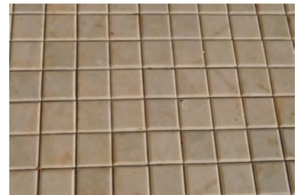
Fig. 452: Detalle del pavimento realizado en mármol de Macael. (Foto: Julia García, 2015)
