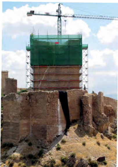
Fig. 175: Trabajos de restauración de la torre del Espolón, Lorca. (Jurado, 2012).
