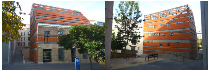
Fig. 625: Vista de la fachada de la Casa del Estudiante con hipogeo al fondo. (Julia García, 2015)
