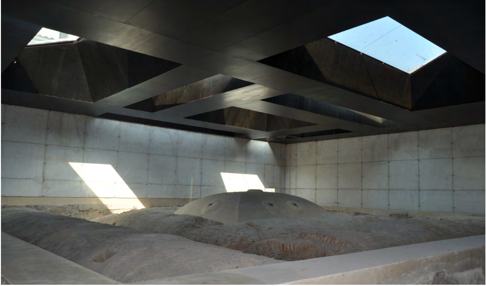
Fig. 393: Cubiertas de los Baños árabes de Baza. (Foto: Julia García, 2013)
