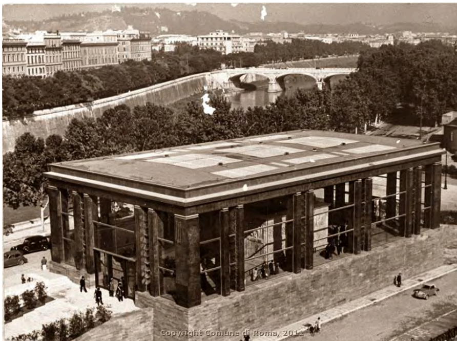
Fig. 685: Construcción del edificio protector del Ara Pacis de Augusto. (Comune di Roma, 2011)
