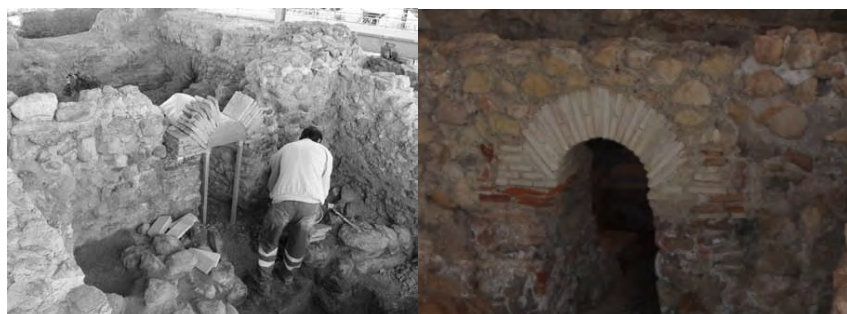
Fig. 266: Reconstrucción de un arco durante el proceso de musealización. (Zapata y González, 2011)
