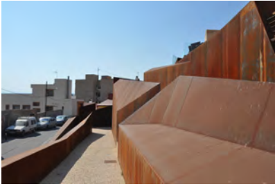
Fig. 326: Pasarela de enlace entre calle Castillo y la calle de Vázquez de Mena. (Foto: Julia García, 2014)
