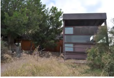
Fig. 144: Vista general del edificio de usos múltiples. (Foto: Julia García, 2015)
