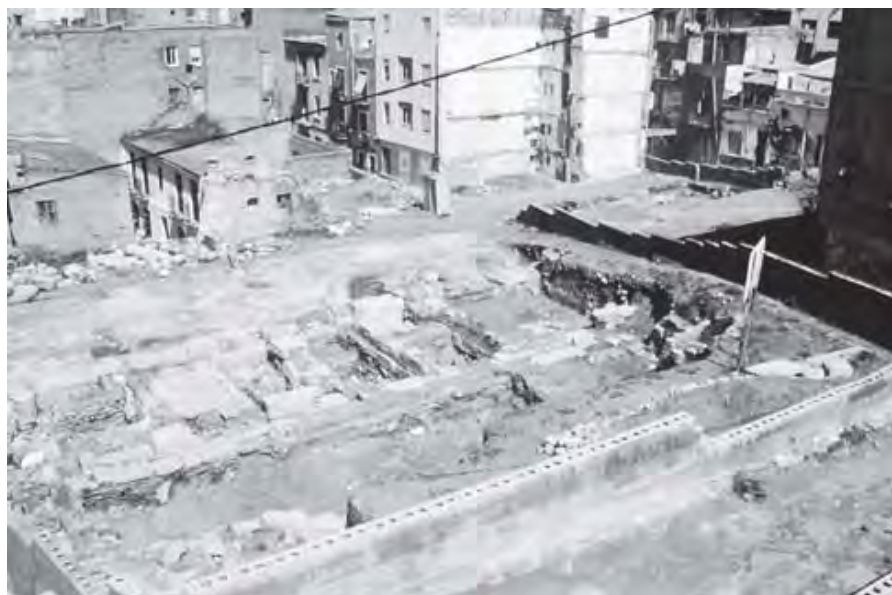
Fig. 106: Vista occidental anterior al inicio de la excavación, a la izquierda se observa el callejón del Junco posteriormente suprimido (Ramallo et alii , 2000)
