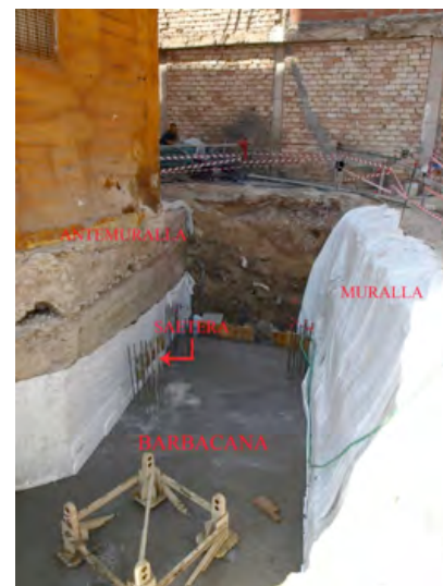
Fig. 380: Elementos que componen el sistema defensivo y losa de hormigón que marca el nivel del futuro Centro de Interpretación. (García, 2010)
