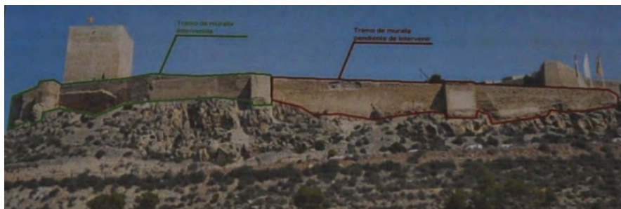
Fig. 174: Lienzo de muralla restaurado en 2011. Delimitado en verde se observa la zona intervenida y en rojo la zona antes de su intervención. (Jurado, 2012).
