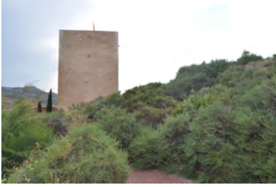
Fig. 137: Imagen actual de la Torre del Espolón sin almenas. (Foto: Julia García, 2015)
