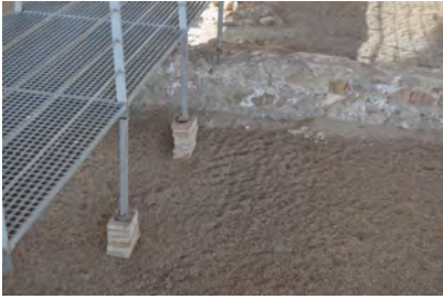
Fig. 257: Apoyo de la estructura de la pasarela sobre recalce. (Foto: Julia García, 2014)
