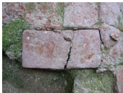
Fig. 406: Solería de ladrillo antes de la restauración. (Ibáñez, 2009)
