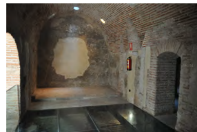
Fig. 415: Sala de agua caliente. (Foto: Julia García, 2012)
