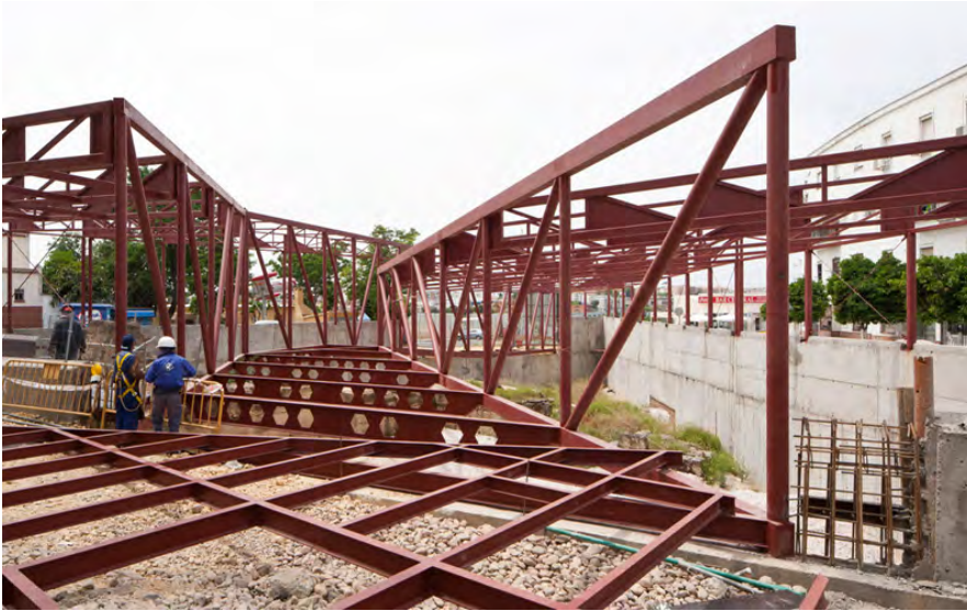
Fig. 471: Estructura metálica del centro de Interpretación. (Estudio Campos Alcaide, en línea)
