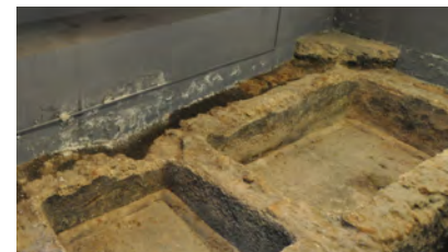
Fig. 429: sales en el muro contemporáneo junto a los tanques de salazones. (Foto: Julia García, 2014)
