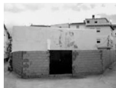
Fig. 399: Situación en la que se encontraban los Baños antes de la intervención de Francisco Ibáñez. (Ibáñez, 2010)
