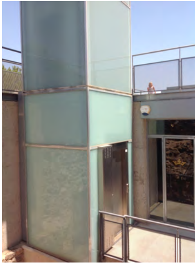
Fig. 365: Ascensor de acceso a la entrada de la Torre del Homenaje. (Foto: Julia García, 2013)
