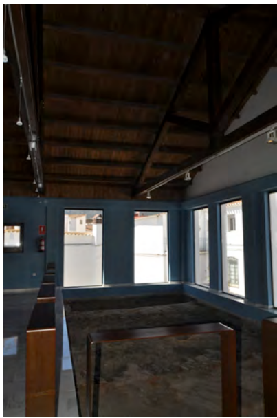
Fig. 436: Vista de la cubierta desde la planta alta. (Foto: Julia García, 2010)
