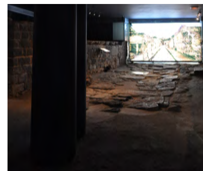
Fig. 522: Disposición de pilares en la intervención realizada por Pedro San Martín en 1974. (Foto: Julia García, 2015)
