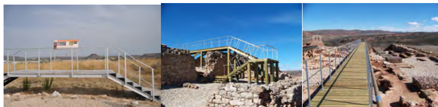
Fig. 301 y 302: Centro y der. Acceso a la pasarela y vista de la misma que permite contemplar el foro de Tiermes. (Foto: Pablo Arribas, 2009)
