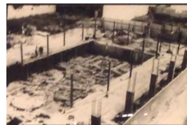
Fig. 345. Construcción de la estructura del museo. (Mas, 1972)
