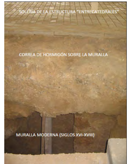
Fig. 455: Apoyo de la correa de hormigón sobre la muralla moderna. (Jurado, 2010)
