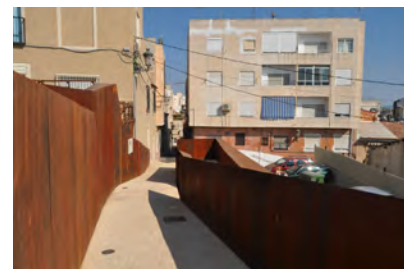
Fig. 327: Pasarela de enlace entre calle Castillo y la calle de Vázquez de Mena. (Foto: Julia García, 2014)
