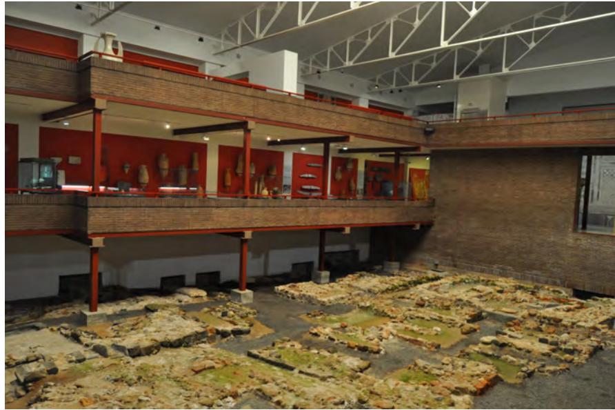
Fig. 343. Sistema de apoyos de vigas en el espacio arqueológico. (Foto: Julia García, 2013)
