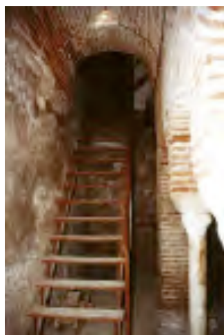
Fig. 408: Escaleras metálicas instaladas durante la actuación dirigida por Prieto Cuellar. (Bertrand, 2003)
