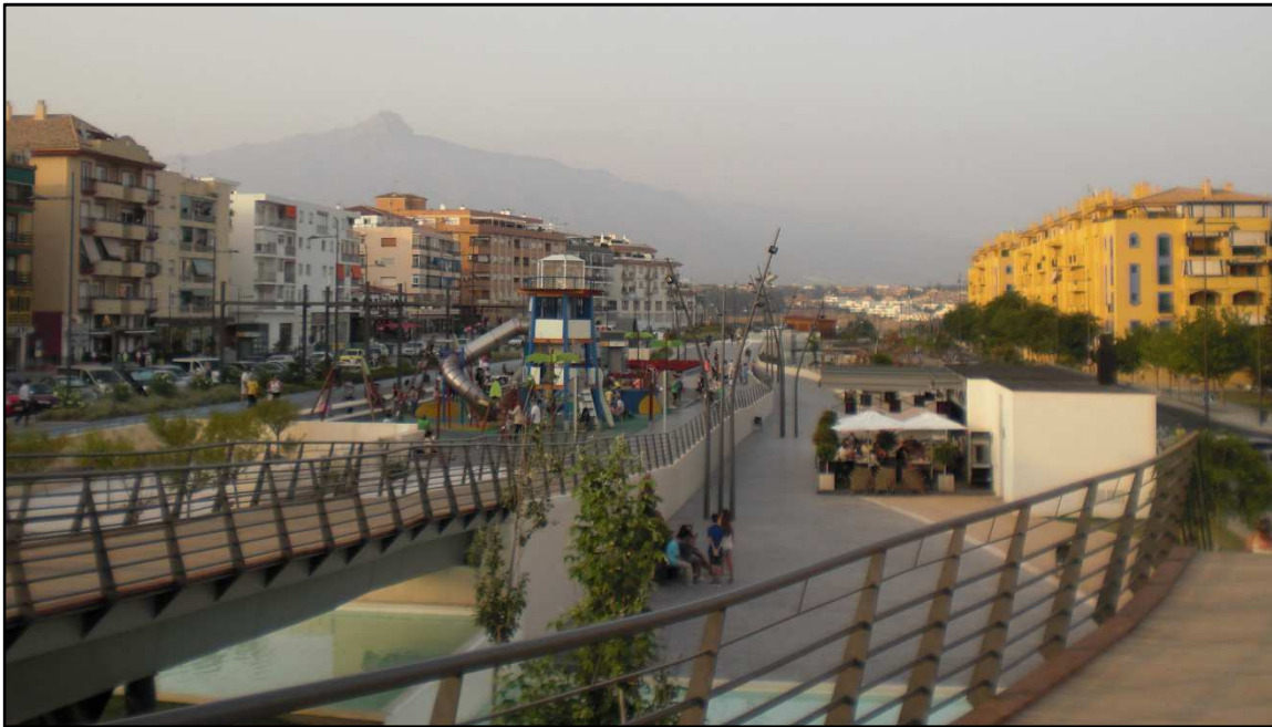
Figura 25. Boulevard de San Pedro de Alcántara (Marbella), tras el soterramiento de la A-7 (antigua N-340) a su paso por la localidad.
