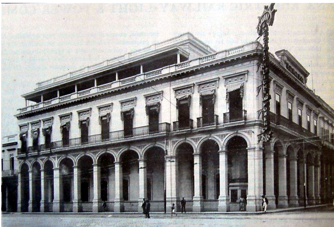
43. Edificio de la HERL, ubicado en la intersección de la calle Egido con la calzada de Monte.
