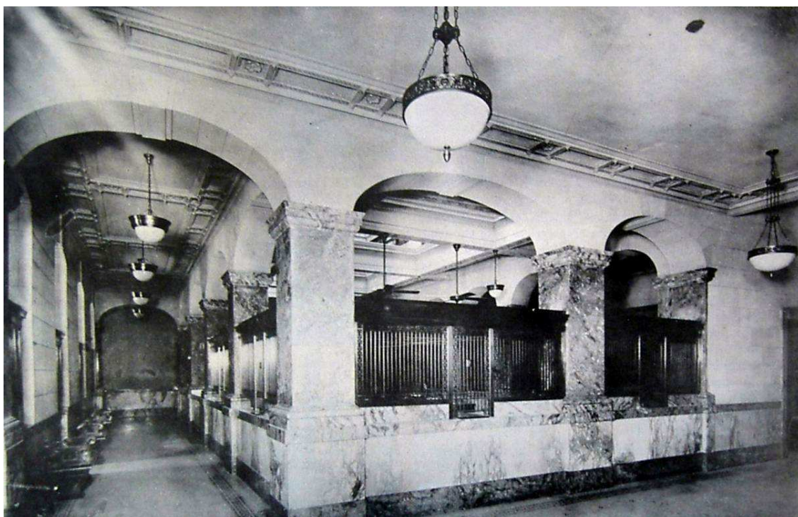
44. Oficinas y cajas del edificio de la HERL.
