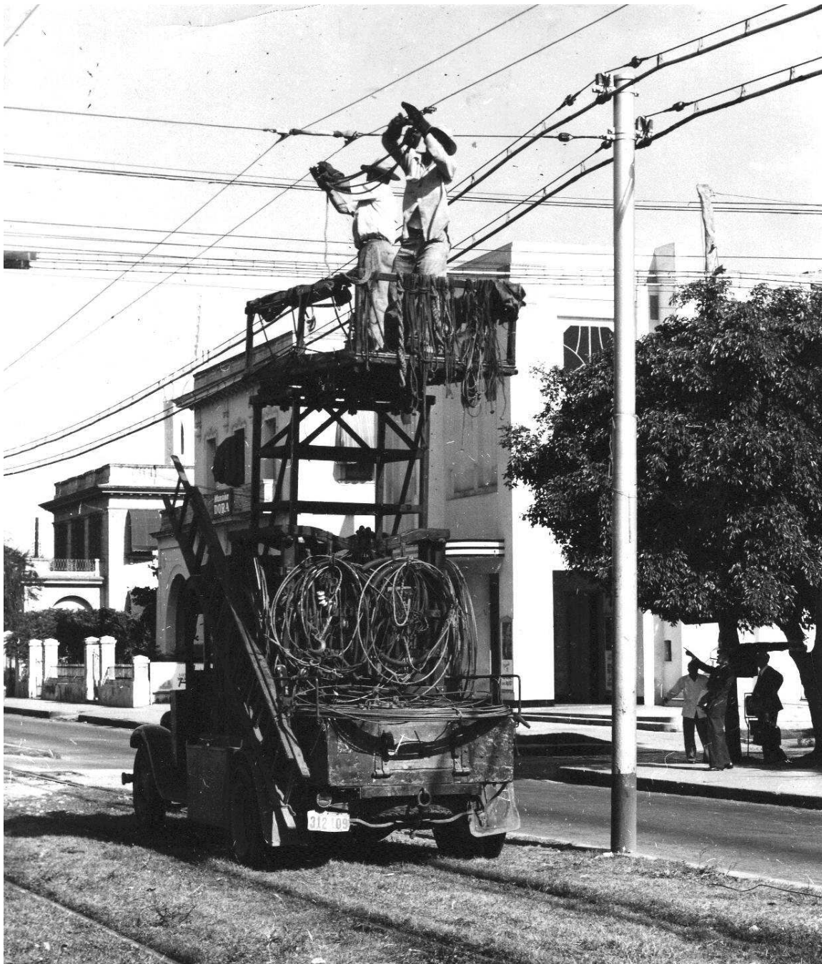
61. Carro torre reparando los cables en la calle Línea, en el Vedado.
