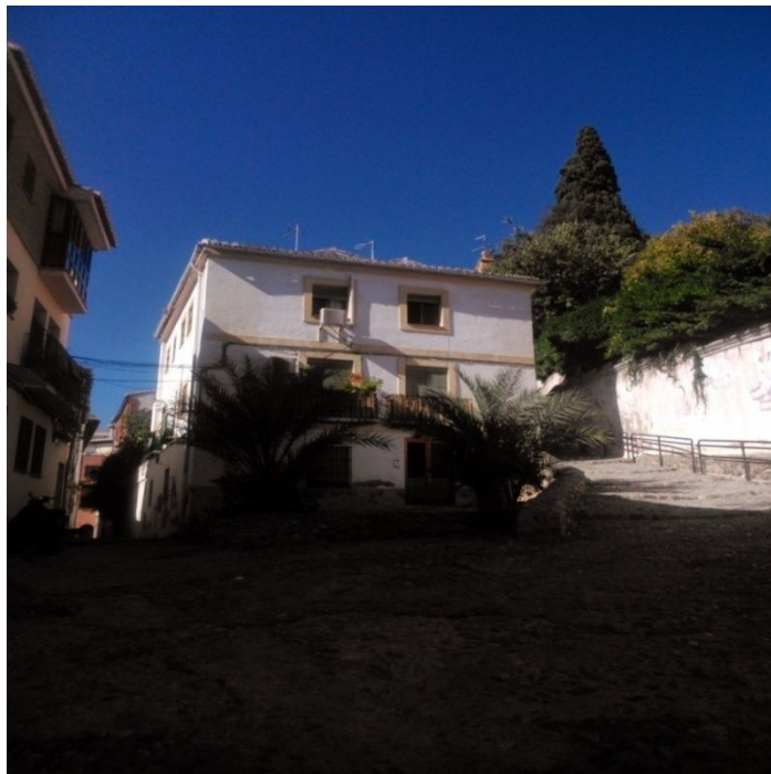
Edificio de Santa Catalina, 3 de febrero del 2014.
