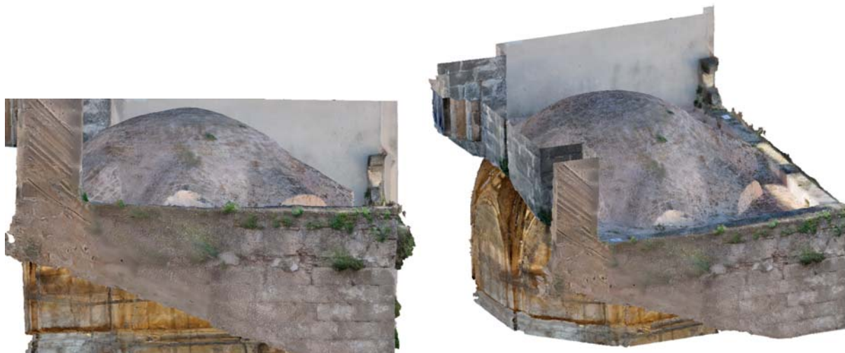
Figura 6. Levantamiento fotogramétrico del trasdós de la bóveda. Con un total de 5E6 caras y con un error del orden de 2 píxeles.
