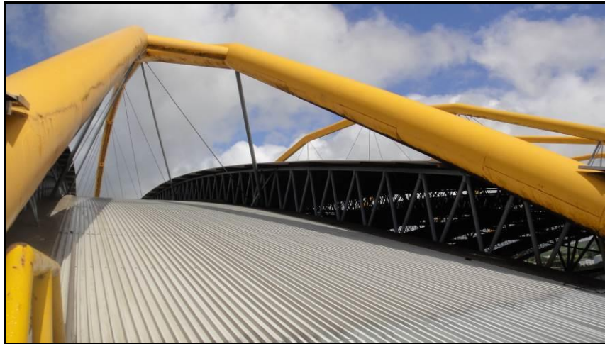
Figura 3. Vista de los arcos y de las cerchas desde la cubierta del nivel inferior
