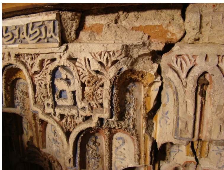
Figura 5.8. Pueden apreciarse pérdidas de soporte, grietas, pérdidas de enjabelgado y ampollas en policromía provocadas por el incendio del s. XIX.
