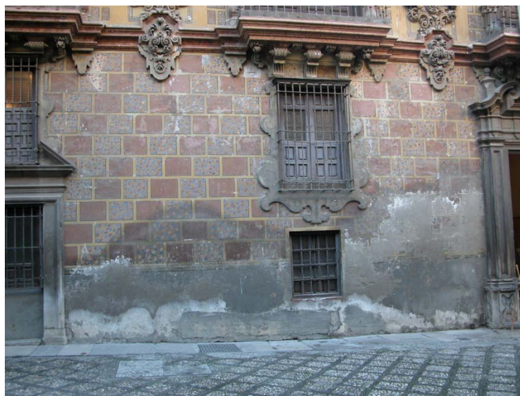
Figura 5.4. Patologías en el primer cuerpo, por humedad y presencia de cemento tipo Portland.
