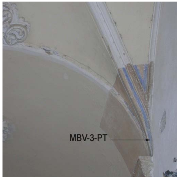
Figura 4.250. Situación de la toma de muestra MBV-3-PT.
