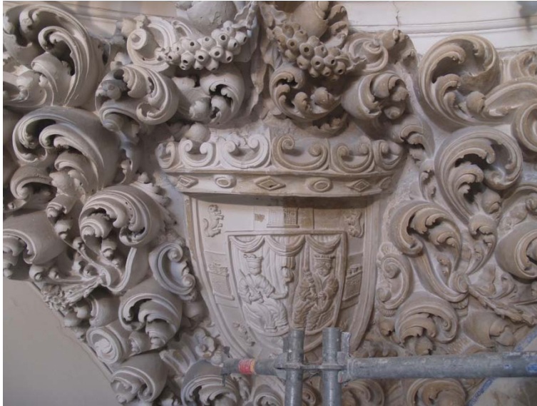
Figura 5.12. Proceso de eliminación de capas en relieves de la cúpula.
