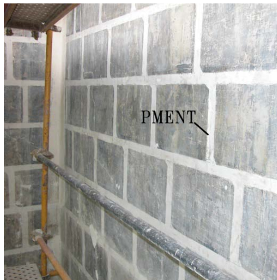
Figura 4.6. Zona de extracción de la muestra PMENT. Entrecalle sillares fingidos.
