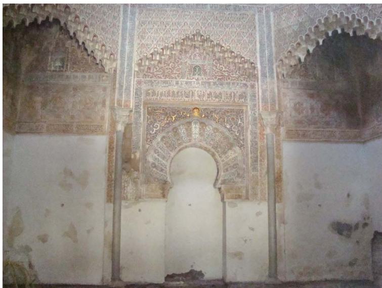
Figura 5.5. Aspecto del testero donde se ubica el Mihrab, antes de la intervención.
