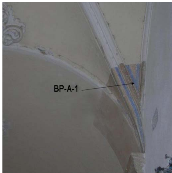
Figura 4.78. Situación de la muestra BP-A-1 de Bóveda de patio. Decoración azul.
