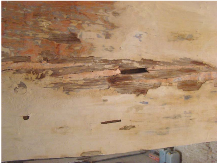
Figura 5.17. Detalle donde se aprecia masilla coloreada rellenando las fendas, así como las capas blanca superpuestas y restos de la azul sobre la policromía original.
