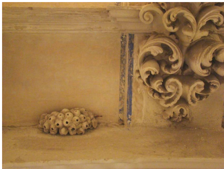
Figura 5.13. Piezas desprendidas y conservadas sobre la cornisa.
