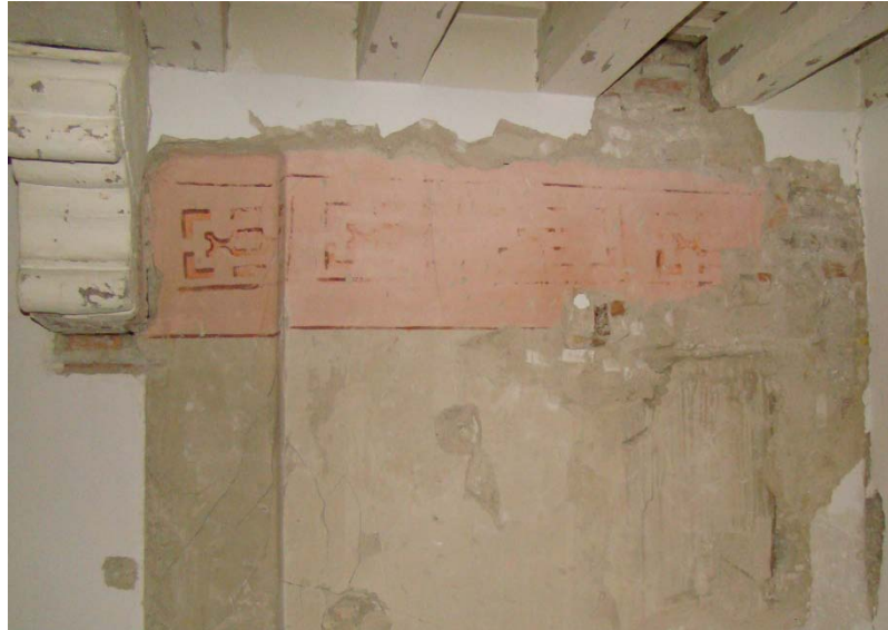
Figura 5.14. Morteros y capas superpuestas a la pintura mural, con falta de cohesión de la capa pictórica y debilitamiento del color.
