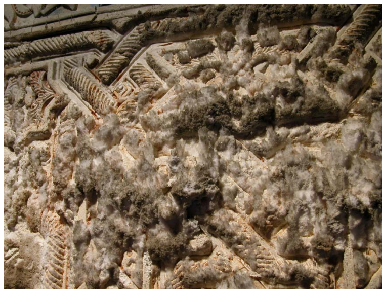
Figura 5.6. Detalle de eflorescencias salinas en yeserías, con polvo acumulado.
