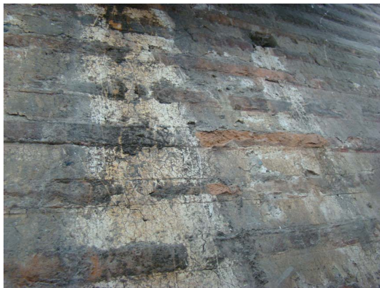
Figura 5.16. Detalle de suciedad adherida al sustrato, con faltas localizadas.
