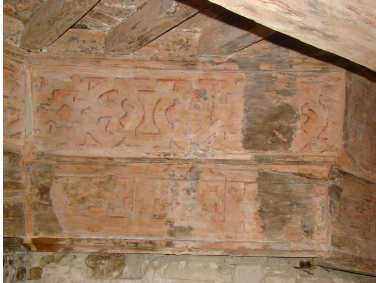
Figura 5.18. Detalle de faltas y desgastes en la policromía.
