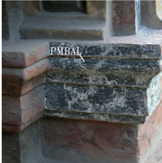
Figura 4.12. Zona de extracción de la muestra PMBAL. Policromía moldura de balcón.
