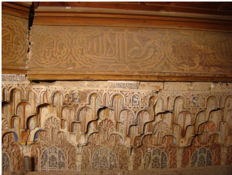
Figura 5.7. Deformación y desplazamiento de los mocárabes por tensiones derivadas del desplazamiento de la armadura.
