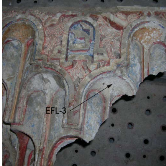
Figura 4.239. Localización del área de extracción de la muestra. Eflorescencias del sector 5 del Oratorio.
