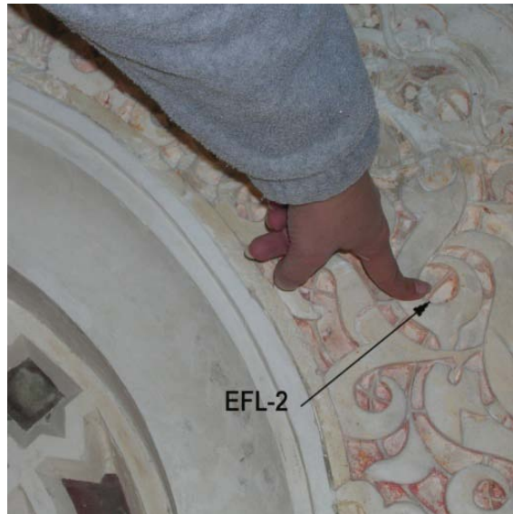
Figura 4.237. Situación de recogida de la muestra en el sector 6 del Oratorio.
