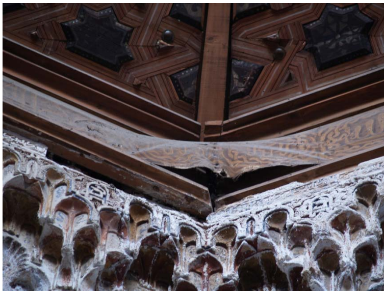
Figura 5.20. Deformaciones con apertura de la armadura, con adición de madera en las uniones de paños. Deformación igualmente del arrocabe realizado en tela de algodón.
