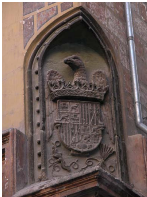
Figura 5.1. Escudo de la fachada en la esquina de calle Oficios y Estribo.
