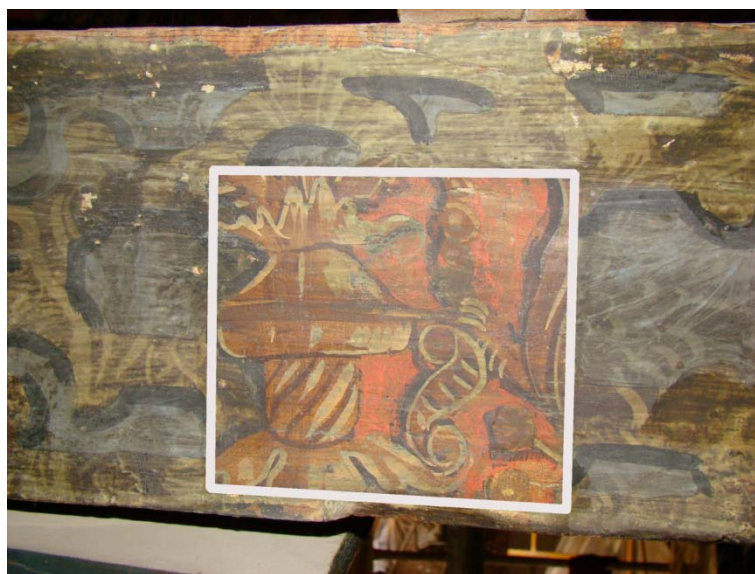
Figura 5.23. Detalle de una cata que deja ver policromía subyacente en los tirantes de la armadura.
