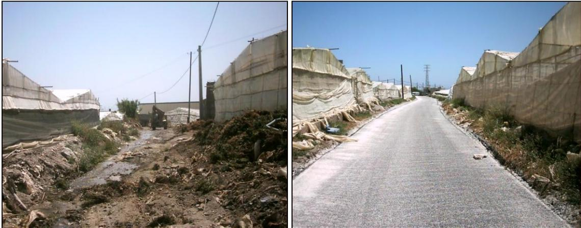
**Fotos 3 y 4:** Ilustraciones en relación a la actuación llevada a cabo en unos caminos rurales en el municipio de Gualchos, Como se deduce de la observación de ellas, se ha recuperado unas vías claramente degradadas y no aptas para el tráfico rodado ni de maquinaria con la consiguiente mejora de las comunicaciones y los rendimientos agrícolas.
