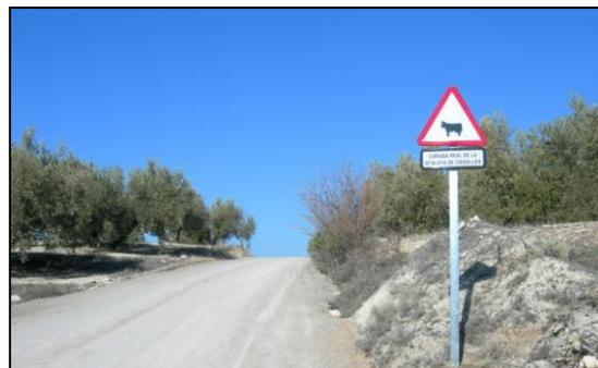
**Foto 5:** Detalle de señalización convencional en Cañada Real de la Atalaya de Cogollos donde se aprecia también el acabado de la misma en zahorra en cumplimiento de la normativa vigente.
