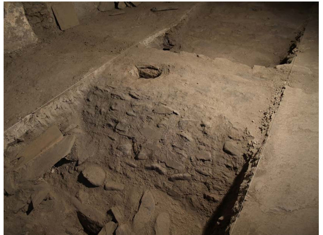
Trasdós de las bóvedas en las que se aprecia la vigería del forjado que se apoyó sobre estas y en la que se han abierto las lucernas. [386]
