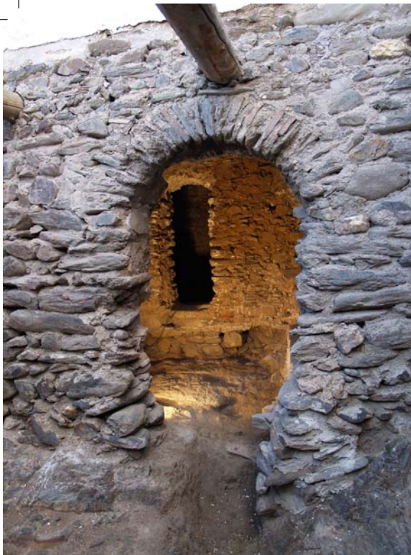
Exterior, fachada oeste, sala 3 acceso principal. [384]
