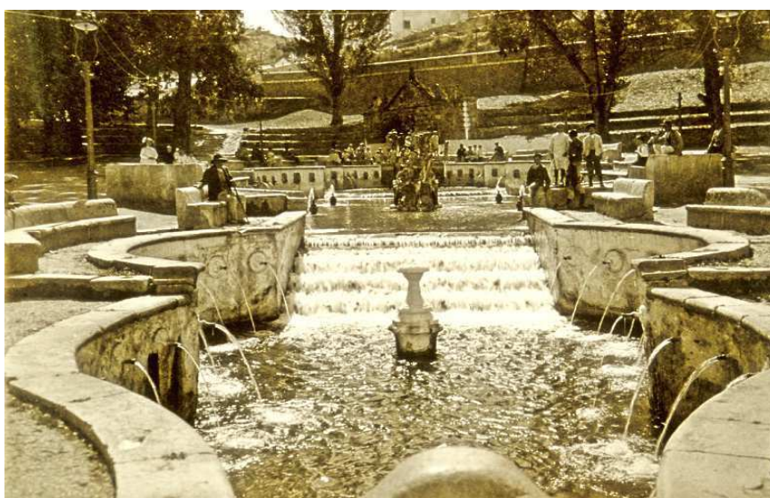
Fuente del Rey de Priego. Autor Fotografía: Castellá.
