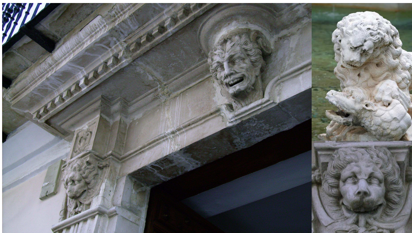
Imágenes Izquierda y Abajo: Figuras del dintel de la casa N o -45 de la Calle del Río de Priego. Imagen Derecha: León despedazando a la serpiente de la Fuente del Rey de Priego.
