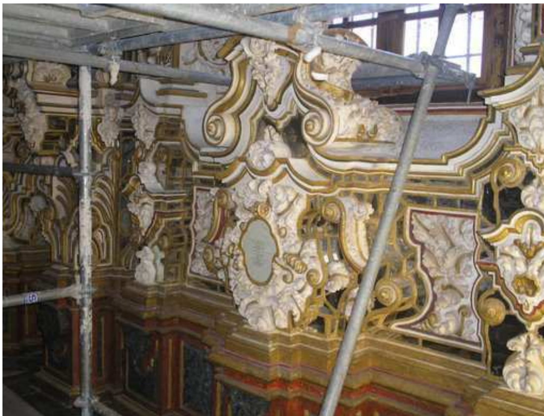
Camarín de la ermita del Cristo del Llano de Baños de la Encina (Jaén), durante su proceso de restauración.
