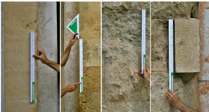
Sillares de la fachada del oratorio al patio
