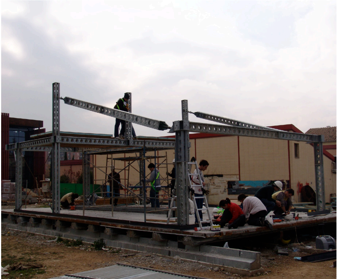
II. x. Proceso de montaje de la estructura del aulario de Aulabierta , diciembre de 2006.
