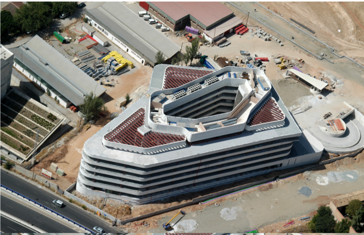
Il. 148. Vistas aéreas sobre la situación de la nave industrial de Diputación de Granada con respecto a la Facultad de Bellas Artes.
