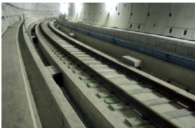
Figura 1: Vía en placa en una sección en túnel (Pañero, 2006).
