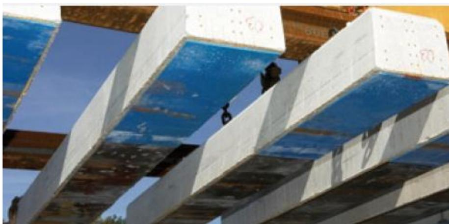
**Figura 55: Aspecto de suelas adheridas a la cara inferior de traviesas de hormigón. (Getzner, [www.getzner.com](http://www.getzner.com)).**
