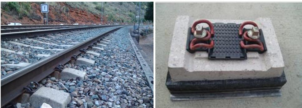
Figura 33: Sistema de sujeción directo, con placa de asiento (Sistema MLG).
