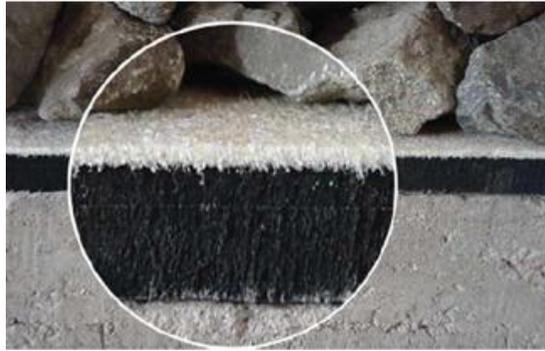
**Figura 73: Manta elástica bajo capa de balasto. CDM (www.cdm.com)**
