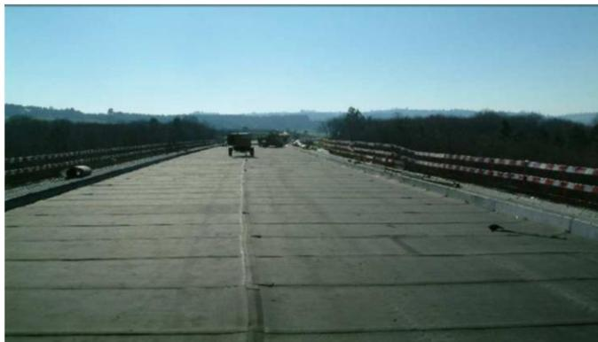
**Figura 74: Aspecto visual de mantas elásticas instaladas sobre un puente, antes del extendido de balasto (Getzner Werkstoffe, 2006).**
