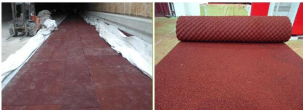
**Figura 83: Manta antivibratoria fabricada a partir de polvo de neumáticos (Sistema MLG).**
