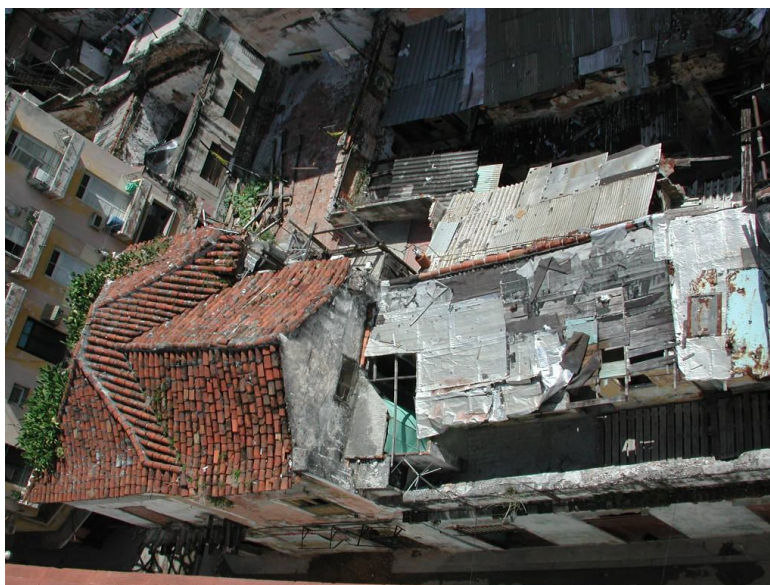
Figura no. 68 Foto de la azotea de la casa del Teniente Rey # 159-161, 1999
