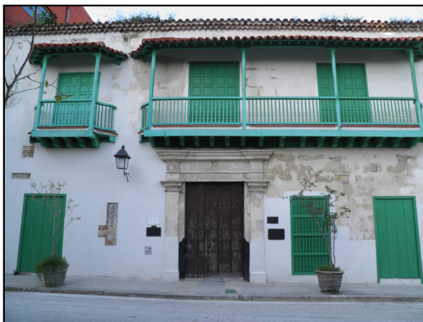
Fachada de Tacón # 12
