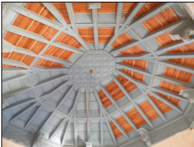
Techo de armadura de madera de la casa de Tacón # 4
