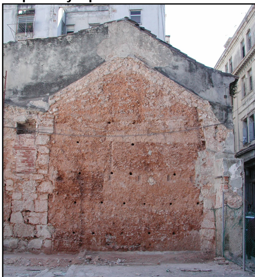
Muro de mampuesto y tapial. Inmueble en la calle Cuba # 407
