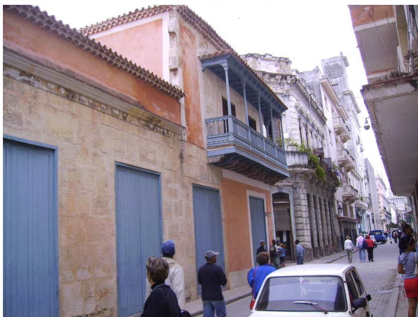
Figura no. 61 Fachada de la casa, 2008
