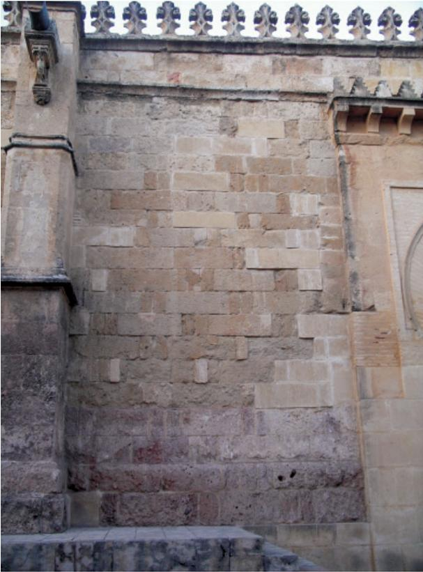
Lám. 10. Muro a N. de la fachada exterior de la Puerta de los Deanes. Se observa el despiece de los sillares grandes del 785 y los pequeños del 951 (Foto: P. Marinetto Sánchez).
