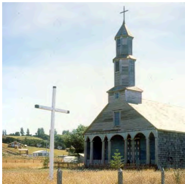
Fig. 119 Fachada Iglesia de Aldachildo, Chiloé.
