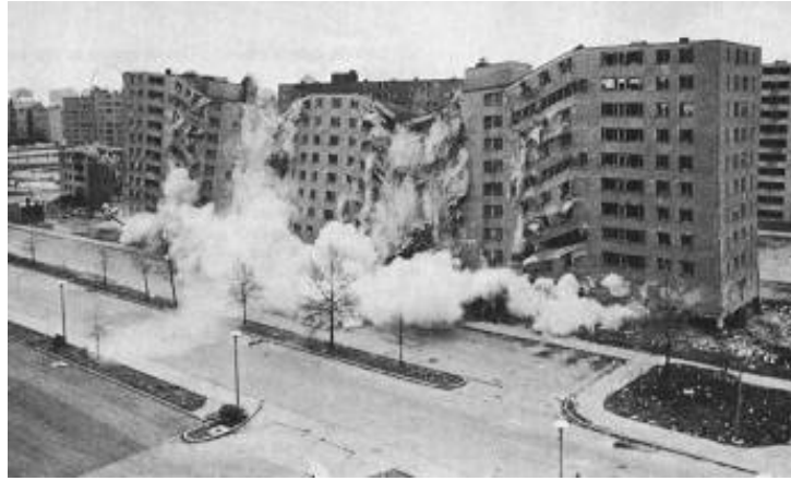
FIG. 17 LA DEMOLICIÓN DEL CONJUNTO RESIDENCIAL PRUITT IGOE. SAINT LOUIS, MISSOURI, EEUU. FIN DEL MOVIMIENTO MODERNO SEGÚN CHARLES JENKS EN HISTORIA DE LA ARQUITECTURA MODERNA. FUENTE: WIKIPEDIA
