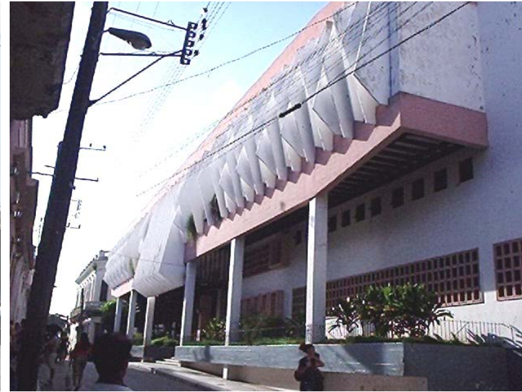
FIG. 66 EDIFICIO “12 PLANTAS”, EN LA CIUDAD DE CIEGO DE ÁVILA, CONSTRUIDO CON EL SISTEMA IMS. RESPONDIENDO A LA IDEA DE UNIDAD HABITACIONAL CON SERVICIOS EN PLANTA BAJA, ESTA TIPOLOGÍA ERA EL SÍMBOLO DE LA MODERNIDAD Y EL DESARROLLO EN LAS PEQUEÑAS CIUDADES DURANTE LOS SETENTA Y OCHENTA. FUENTE: GONZALEZ COURET [2009]
